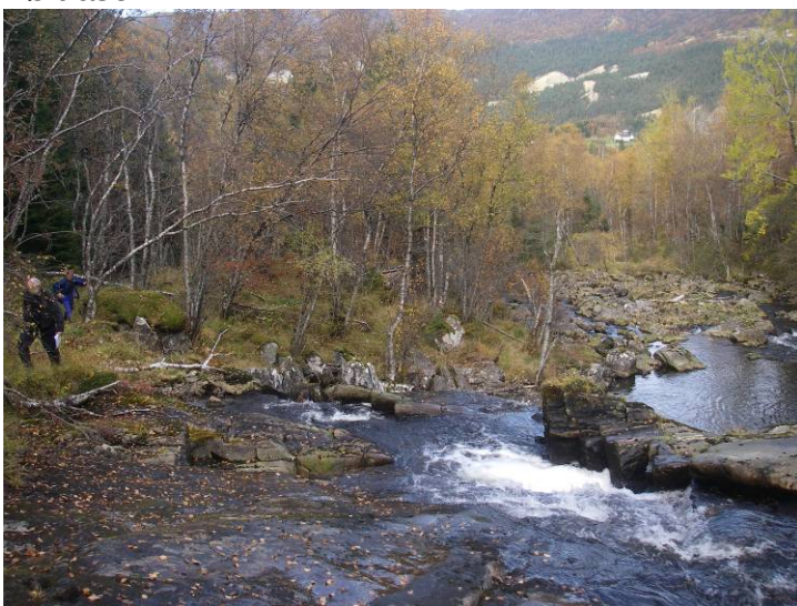
Oversikt kraftstasjonsområde og fylkesvei.
