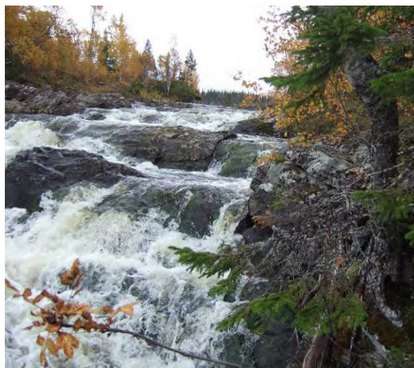
Område inntaksdam sett nedenifra.
