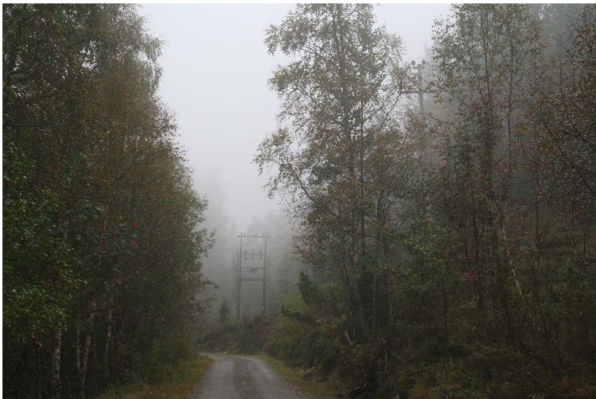
Foto 5 Parti langs veien på øvre del av rørtasè sett mot inntak. Rør vil bli gravd ned på nedsiden av veien, til venstre i bilde.
