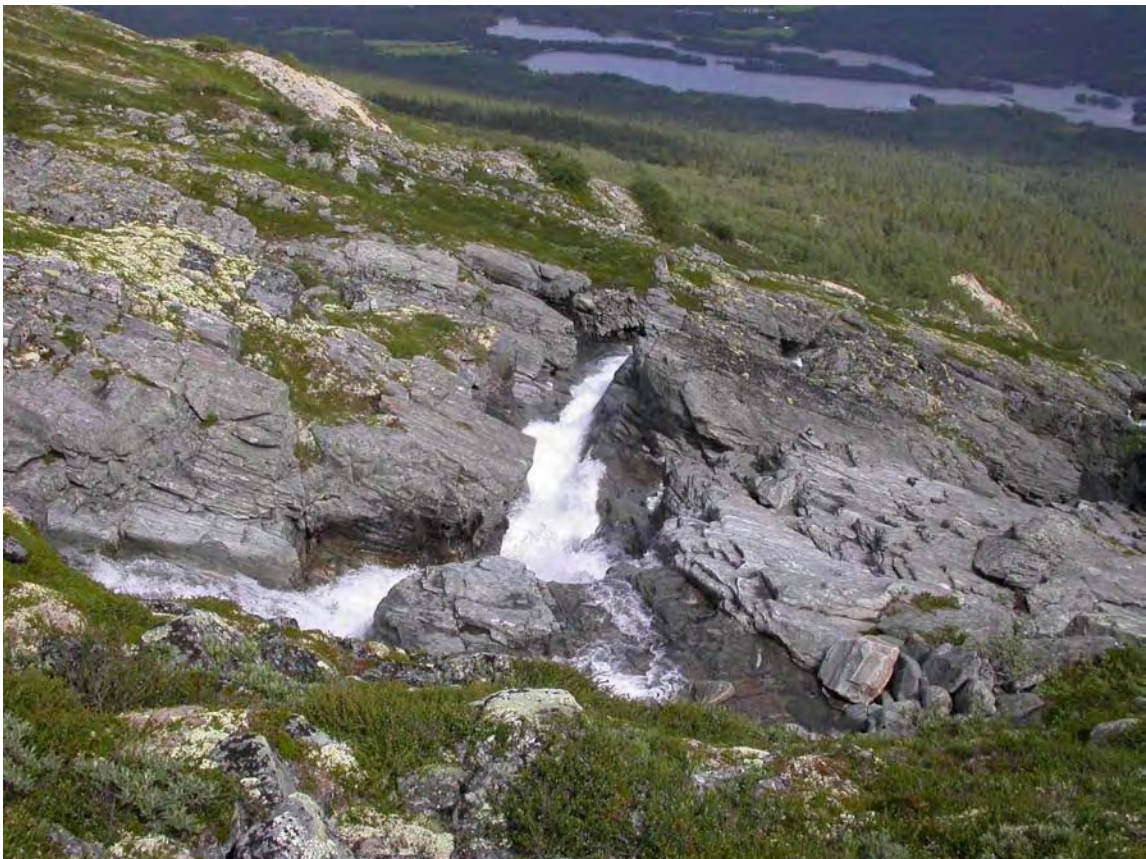
Figur 10. Dette er trolig den beste plassen for inntaksdam. Stedet ligger ca 50 høydemeter ovenfor Valåfossen. I bakgrunnen kan skimtes deler av Lesjaskogsvatnet.
