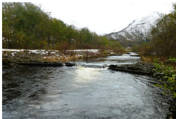
Figur 5. Oselva. Venstre: Opp mot Sjørdalsvatnet flatar elva ut og renn svært roleg. Oppe til høgre, i midtre parti renn elven jamt, elva er forbygd mot jordbruksområder på autssida. Nede: I nedre del er elva terskla.
