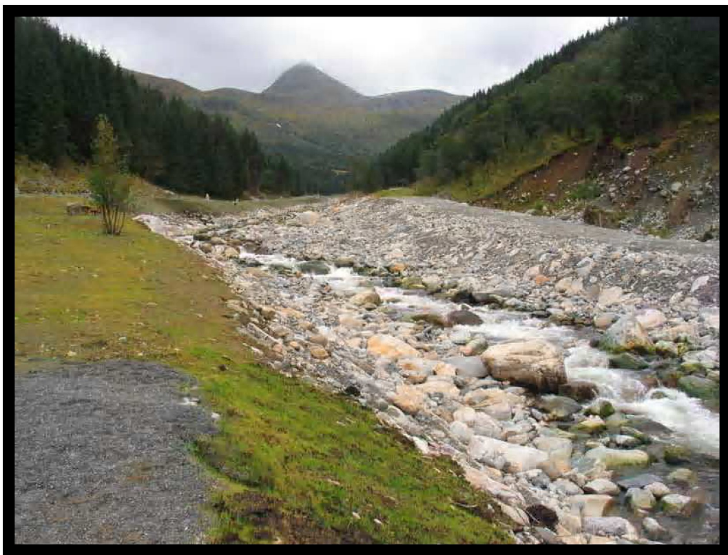
Ripsdalselva, rensket og forbygget etter flom i 2004. Alle fotos: T.O.Nordvik
