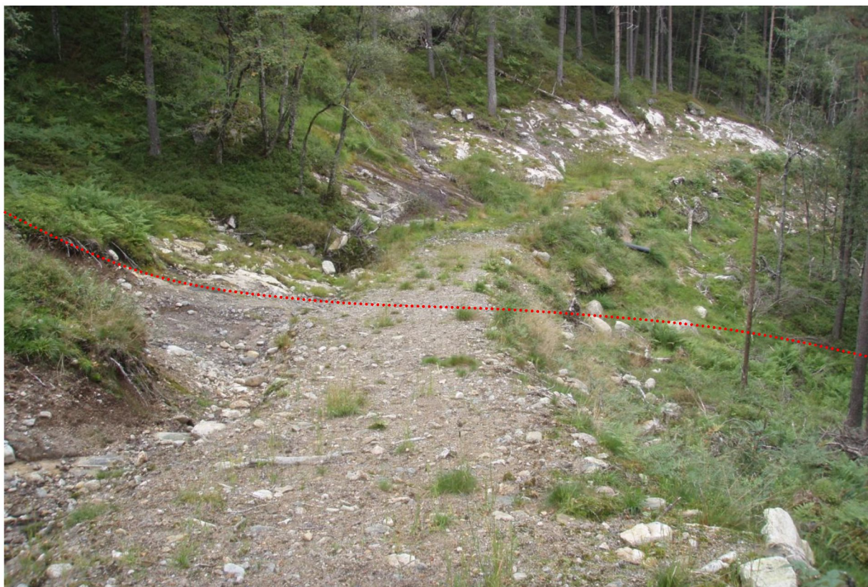
Figur 6: Område der planlagt rørgrøft krysser eksisterende skogsvei
