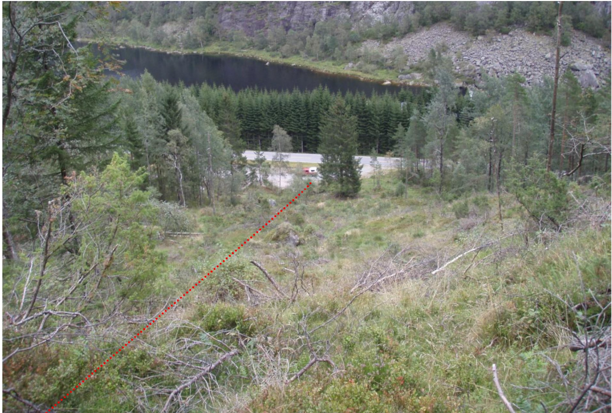
Figur 7: Hogstflate i lia ved riksveien. Kraftstasjon planlagt på tømmerlagringsplass i enden av stiplet linje.
