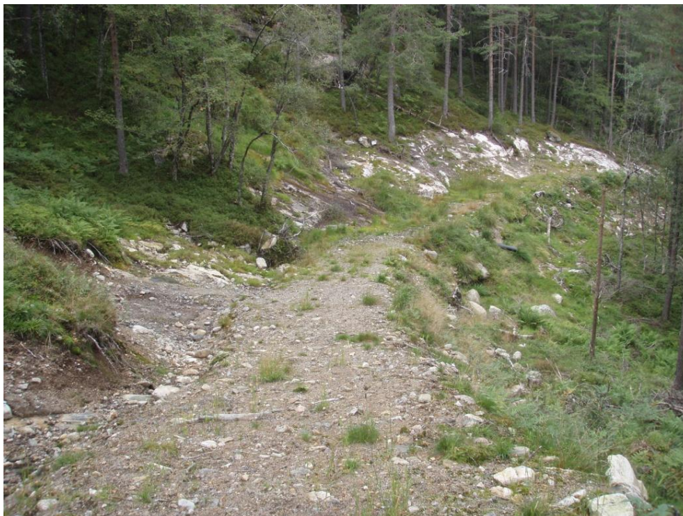
Figur 6. Det er allerede bygd skogbruksveg, klasse 7, for nedre deler av trase for rørgate.
