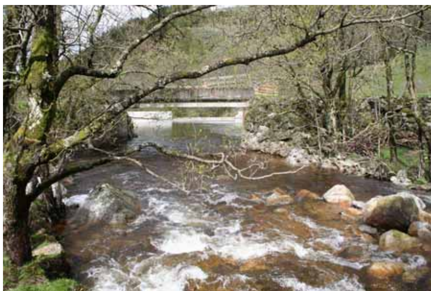
Bilde 12 Elveparti like oppfor eksisterende inntak.
