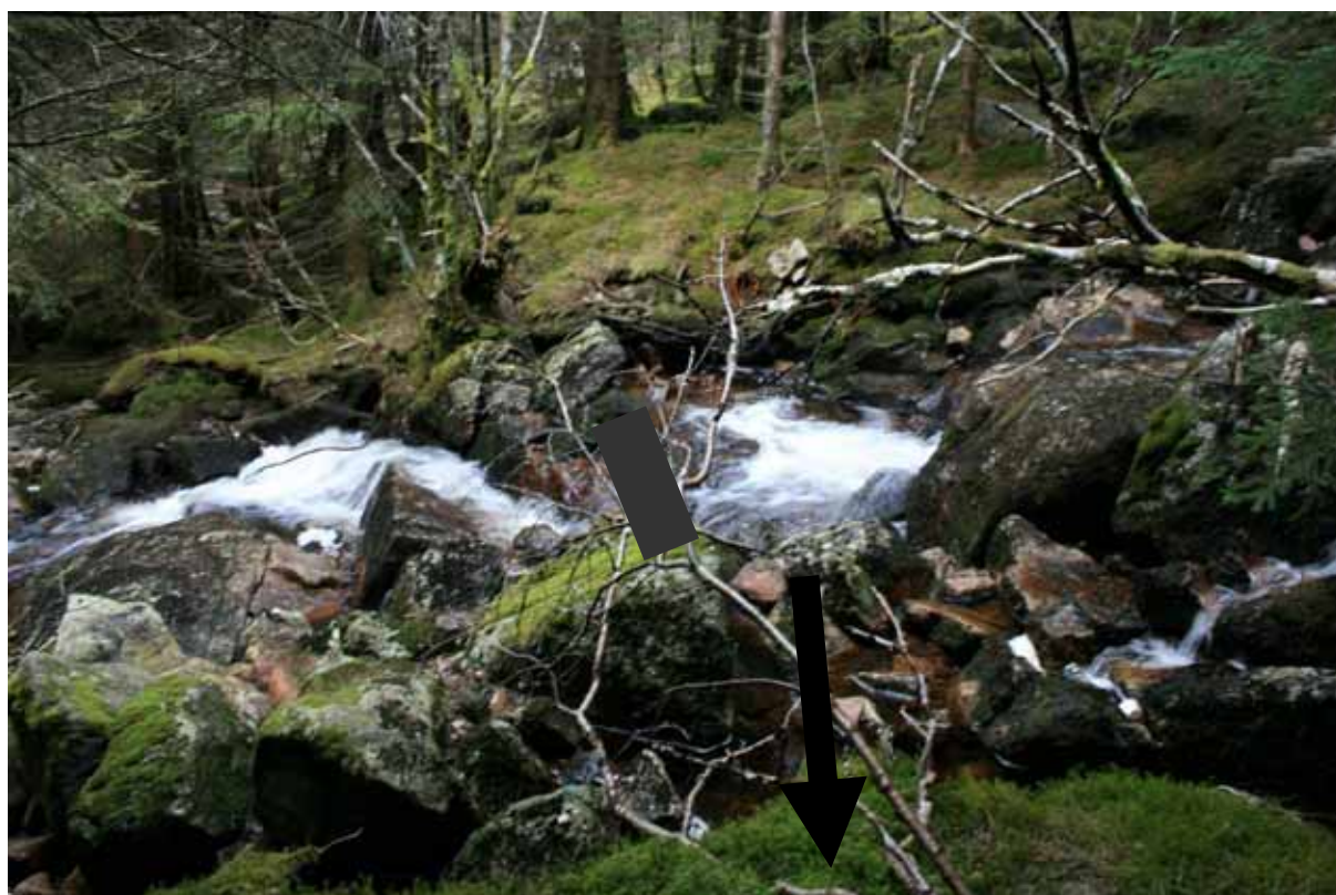
Bilde 2 Inntak Måbekken sett fra øst, pil viser hvor overføringsrør er planlagt.
