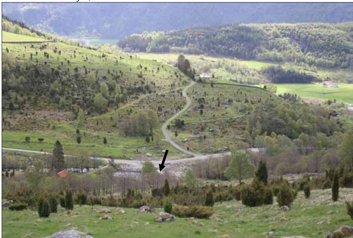
Bilde 8 Eksisterende inntak trinn I (pil).
