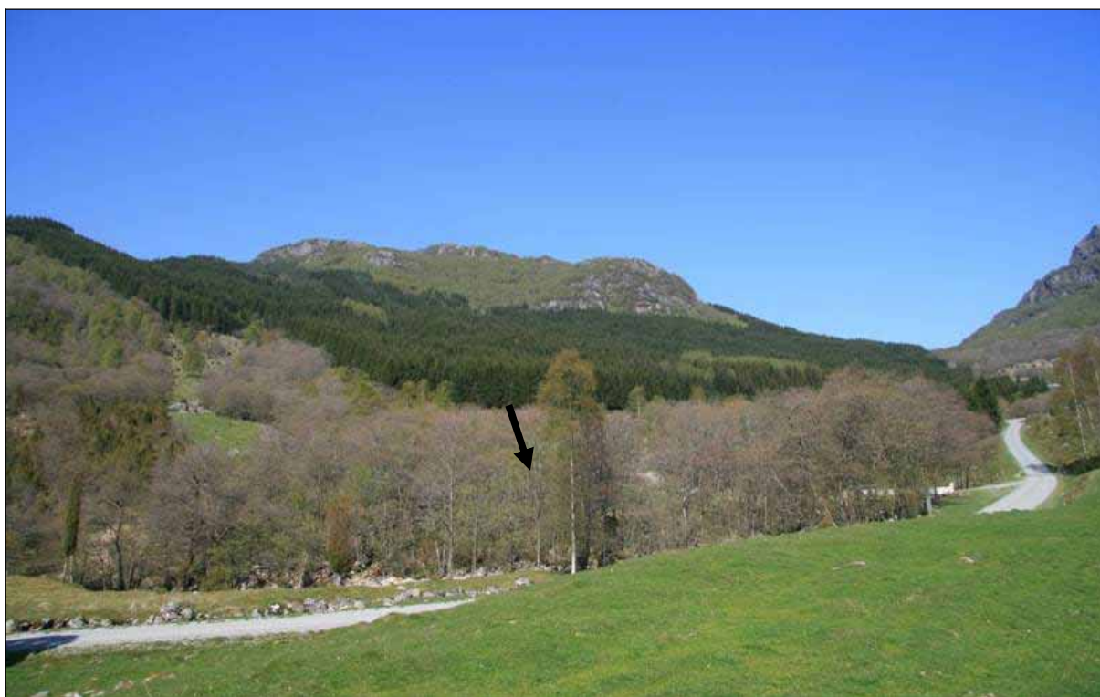
Bilde 9 Kraftstasjon trinn II, inntegnet pil. Eksisterende inntak utfor bildet til venstre.
