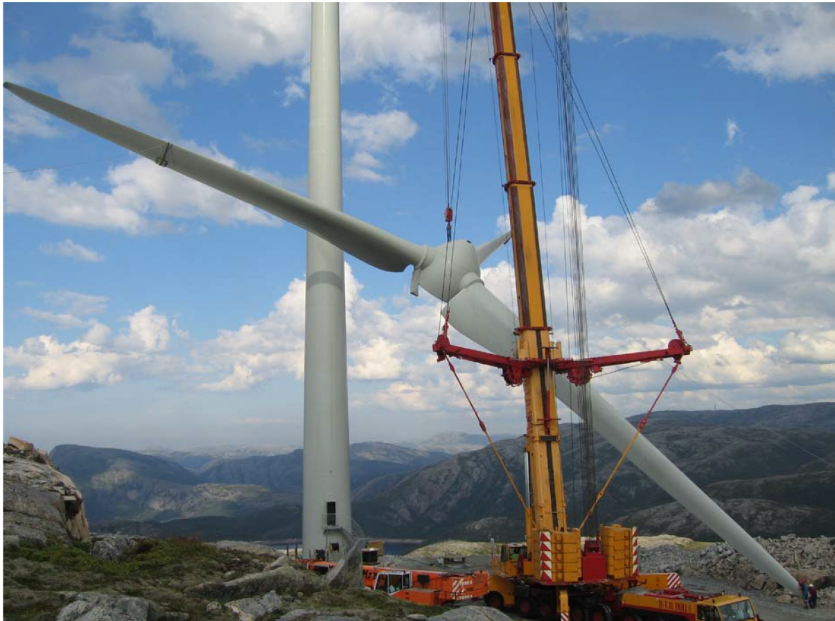
Figur 17 : Løfting av nav m/vinger på Bessakerfjellet.
