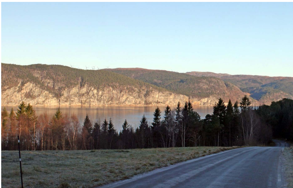
Figur 27 : Engvikfjellet vindkraftverk sett fra Ytre Snillfjord.
