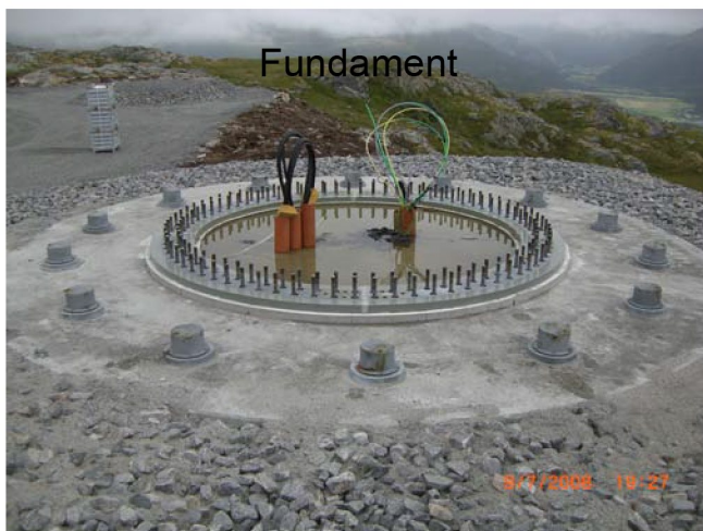
Figur 18 : Ferdig støpt og omfylt fundament
