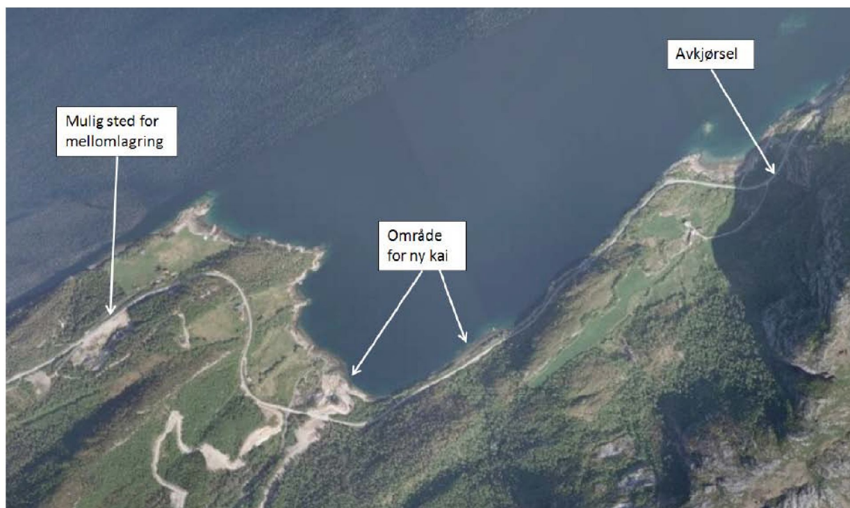
Figur 14 : Bildet viser mulig område for ny kai i Åstfjorden, samt område for mellomlagring av vindturbiner og avkjørsel opp til vindkraftverket.
