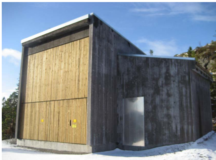
Figur 10 : Transformatorstasjonen i Bessakerfjellet vindkraftverk
