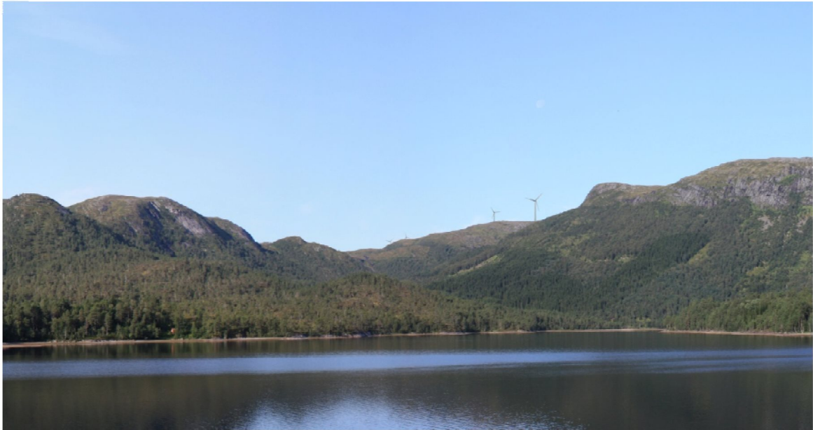
Figur 10: Fra østsiden av parken og Slørdalsvatnet er kun få av turbinene synlige
