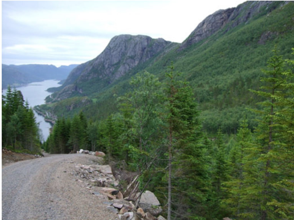
Avsnitt av den nyanlagte anleggsveien med lia i bakgrunnen hvor adkomstveien til vindkraftverket er planlagt. Foto: Morten W. Melby
