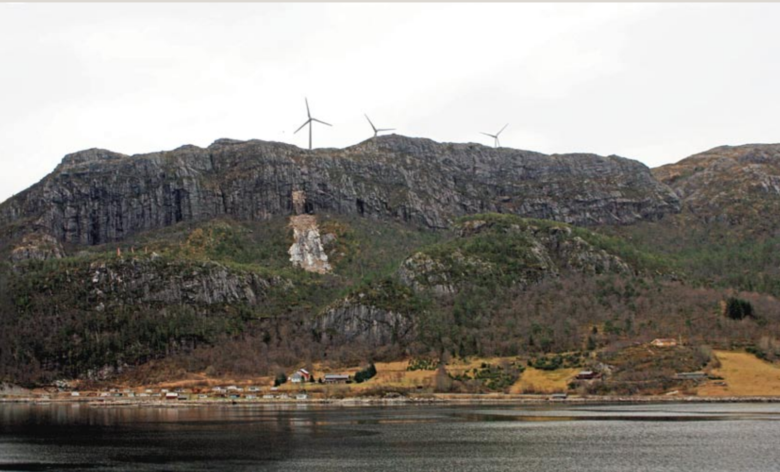
Engvikfjellet vindkraftverk sett fra Vågan.
