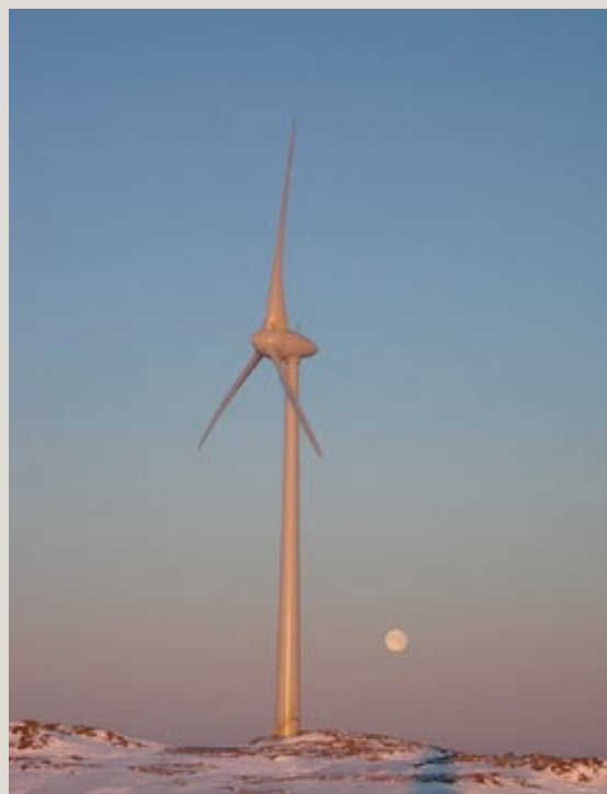
Bildet viser en vindturbin på 2.3 MW, fra TrønderEnergi sitt vindkraftverk på Bessakerfjellet i Roan kommune.
