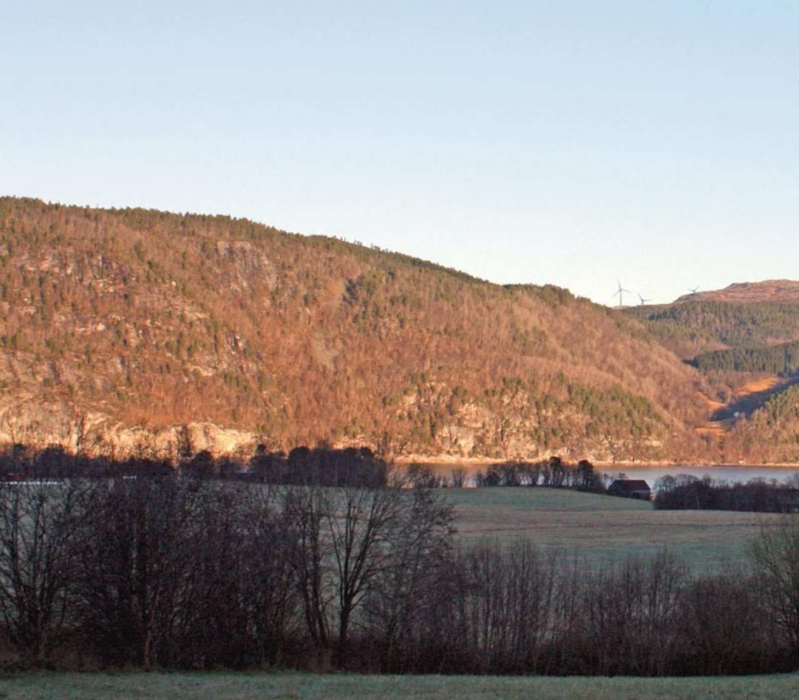
Engvikfjellet vindkraftverk med utsikt fra Ytre Snillfjord.
