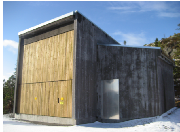
Figur 7: Transformatorbygg i Bessakerfjellet vindmøllepark
