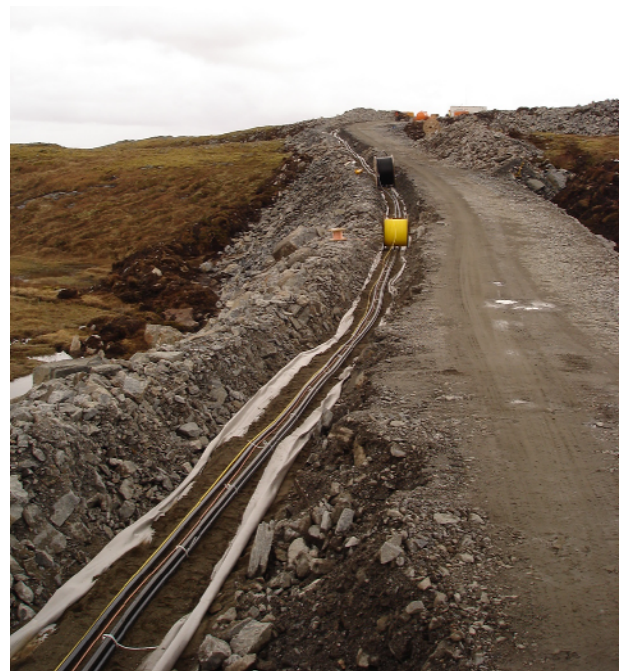
Figur 6: 22 kV-kablene fra hver mølle graves ned i vegskulderen på Bessakerfjellet
