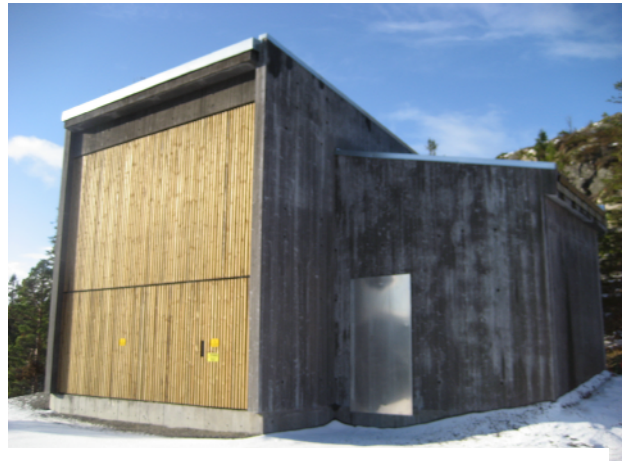
Figur 7: Transformatorbygg i Bessakerfjellet vindmøllepark
