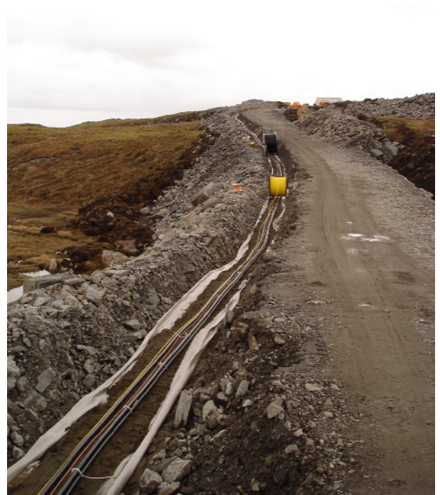
Figur 6: 22 kV-kablene fra hver mølle graves ned i vegskulderen på Bessakerfjellet
