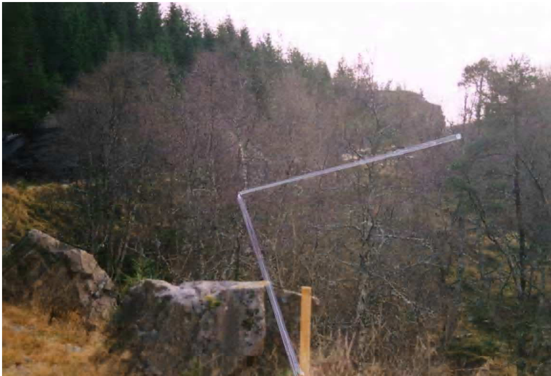
Figur 4.8: Bildet tatt omtrent 500 meter nedenfor Brattbakkan opp mot toppen, hvor rørtrasé er skissert med hvit heltrukken linje.
