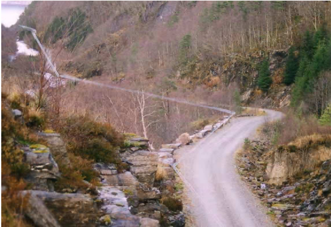
Figur 4.7: Bildet tatt på Brattbakkan, hvor rørtrasé er skissert med hvit heltrukken linje.
