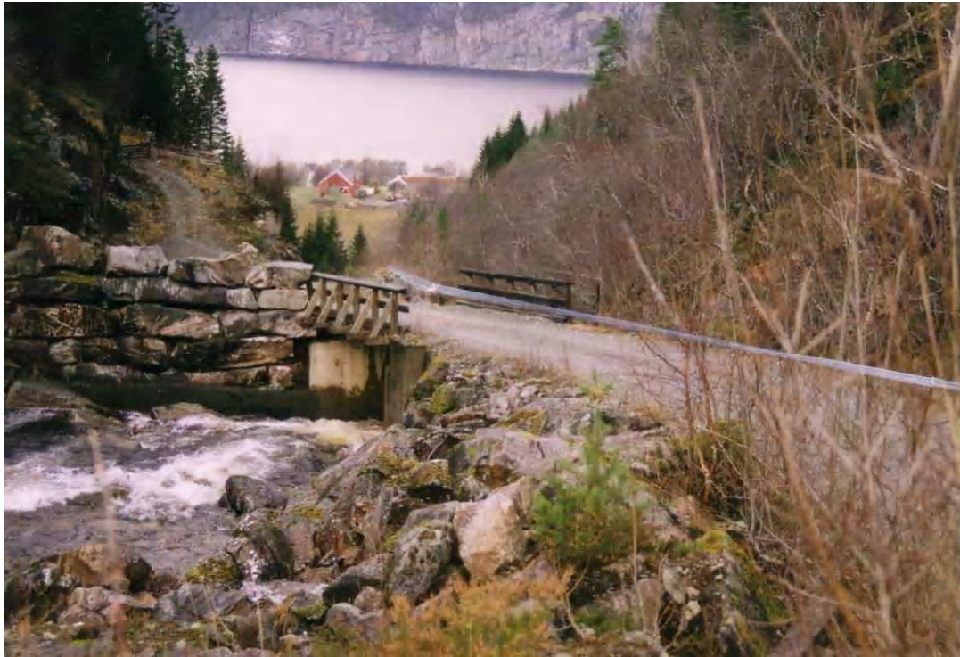
Figur 4.15: Brua midt i dalen.
