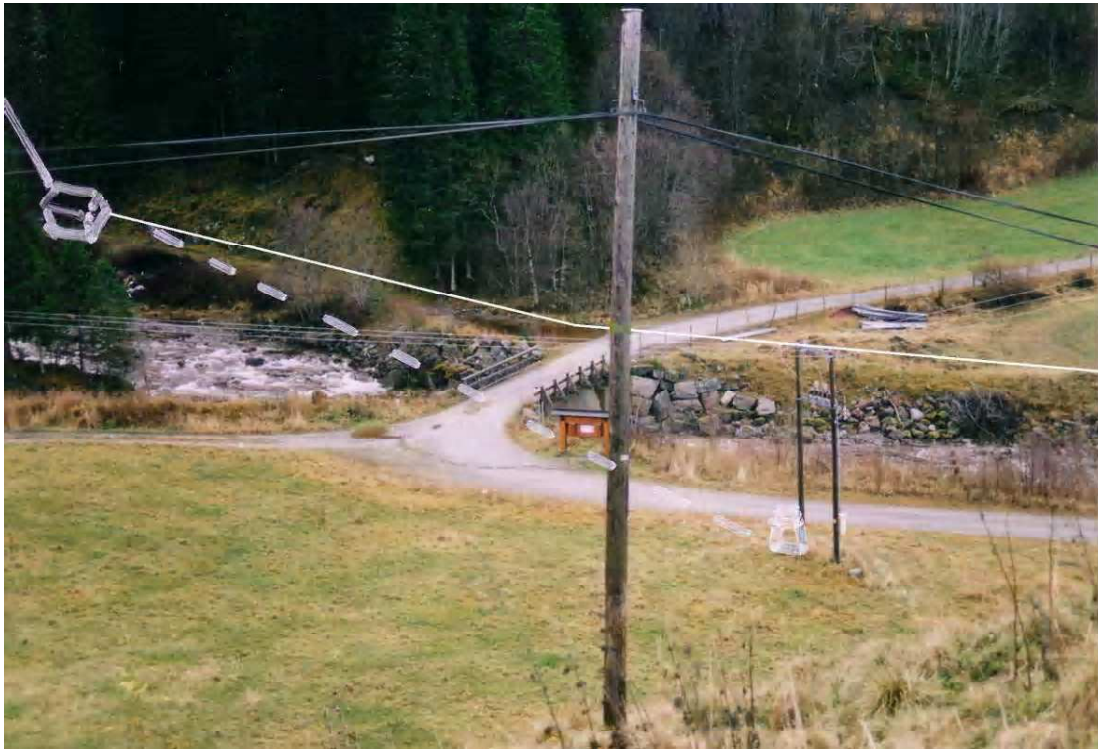
Figur 4.17: Brua over Vennaelva bakenfor Vennagårdene. Trasé for nedgravd jordkabel i heltrukken hvit linje – stiplet linje opprinnelig forslag.
