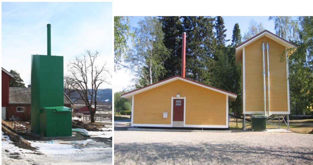
Bilde 1. Mobil biokjel både med og uten nedgravd silo.
