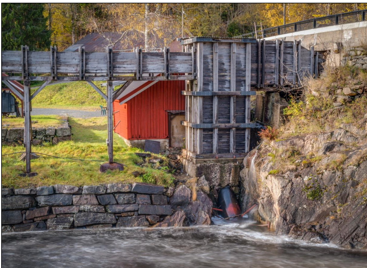
Her ser en ny vannrenne, sump og utløpsrør.
