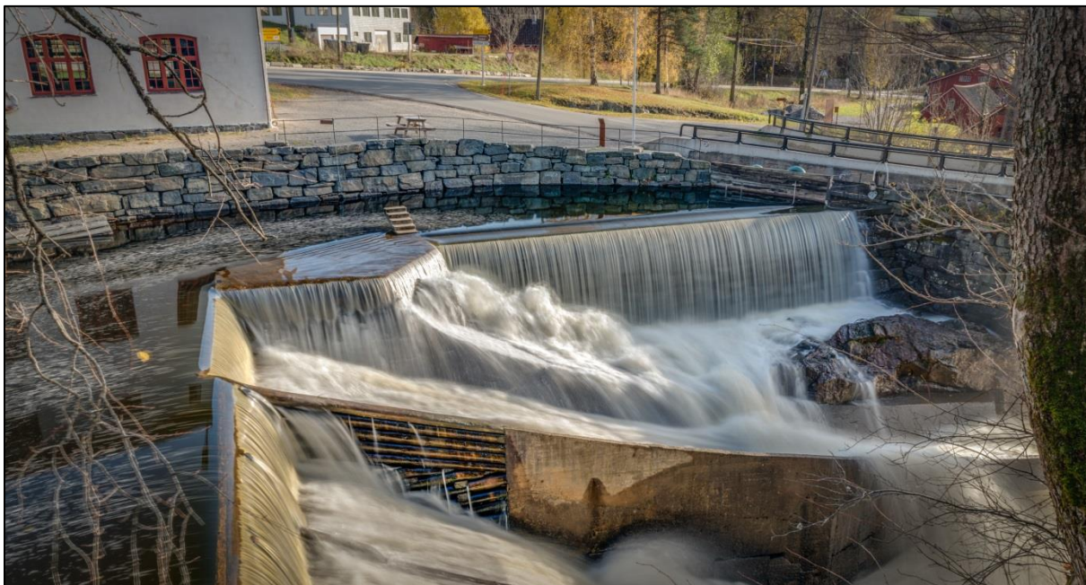
Her ses Hammerdammen med sidekanalen med flomoverløp. Inntaket til minikraftverket vil bli plassert helt i høyre kant av sidekanalen.
