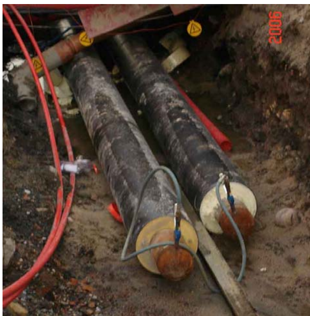
Figur 7 Fjernvarmerør i grøft
