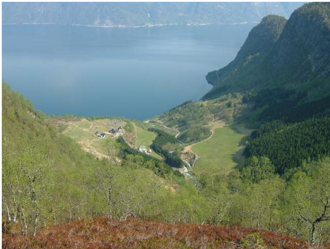
Oversiktsbilde ned mot kraftstasjonen
