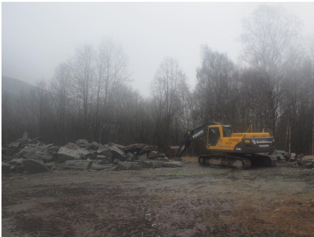
Figur 2-17 Kraftstasjonsområde for Øla kraftverk. Gravemaskin markerer tomt for kraftstasjon.
