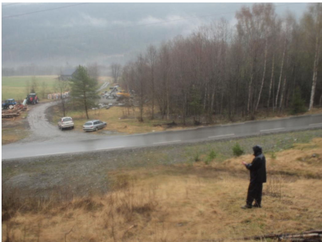
Figur 2-13 Rørtrase ned mot kraftstasjon.
