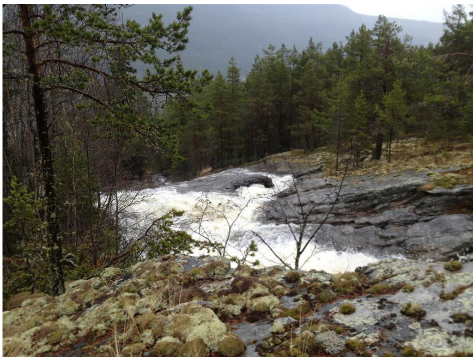
Figur 3-11 Flomløp som tar av 200 m oppstrøms brua ved Stigen og der det vil bli satt opp sperre.
