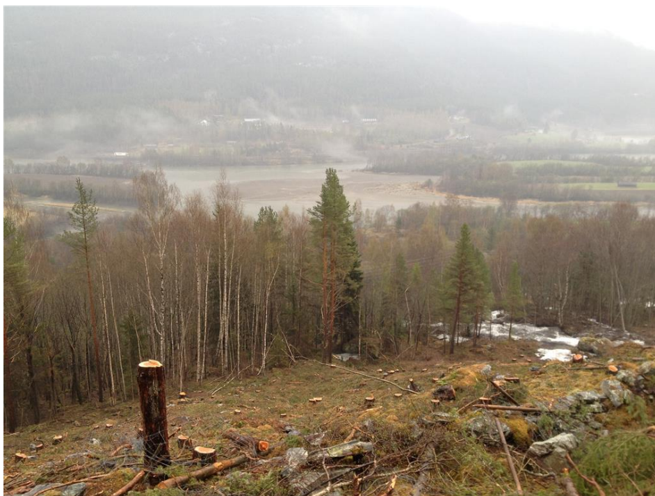
Figur 3-8. Avskoget område ved Einstapptykkja der ny E6 skal bygges. Øla i bakgrunnen, planlagt rørtrase vil gå i venstre kant av bildet gjennom registrert naturtype rik blandingsskog.
