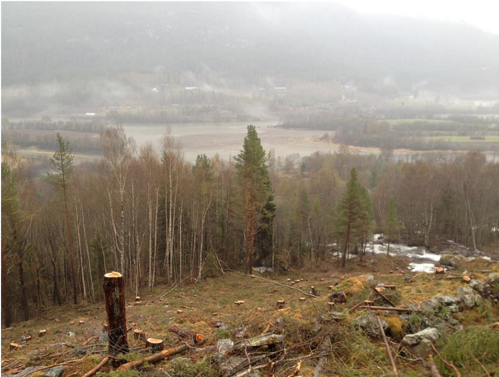
Figur 7. Avskoget område ved Einstappplykkja der ny E6 skal bygges. Øla i bakgrunnen, planlagt rørtrase vil gå i venstre kant av bildet gjennom registrert naturtype rik blandingsskog.
