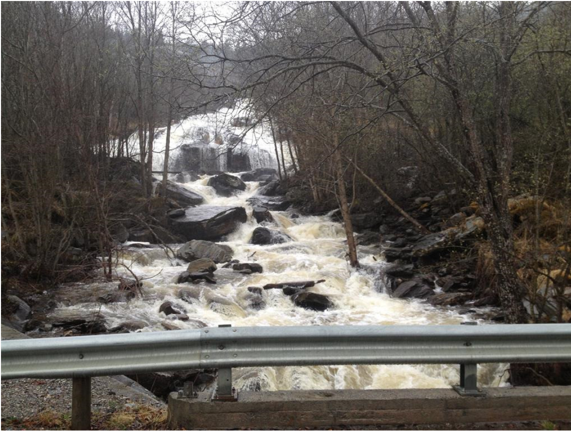
Figur 8. Øla like oppstrøms brua over fylkesveien med vandringshinder for fisk i bakgrunnen. Ny trase for E6 ligger ca. 100 m ovenfor brua.
