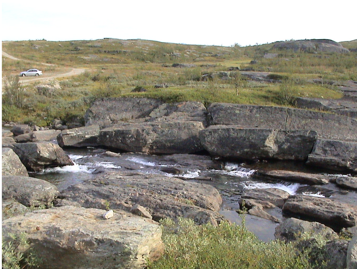
Bilde 1.2 Eksisterende demning sett mot øst med vei i bakgrunn
