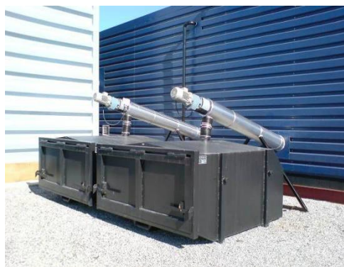
Multisyklon og eksempel på todelt askeløsning (foto SWECO Norge AS)
