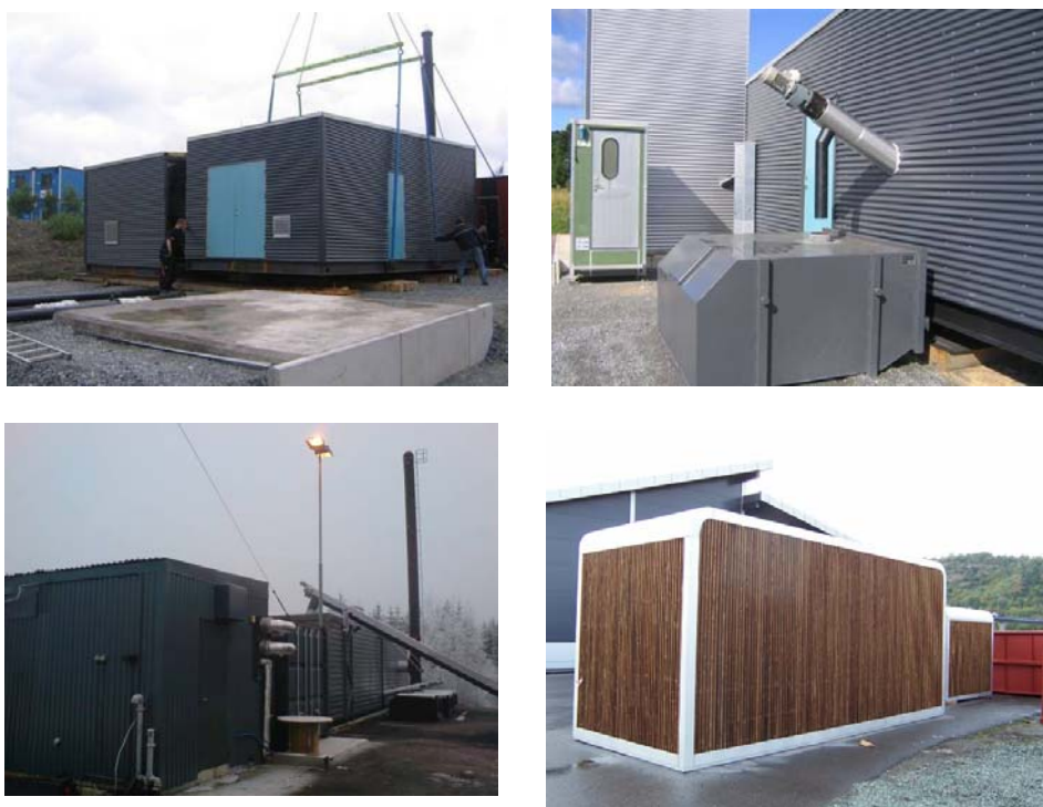
Diverse prefabrikkerte energisentraler (foto: SWECO Norge AS)
