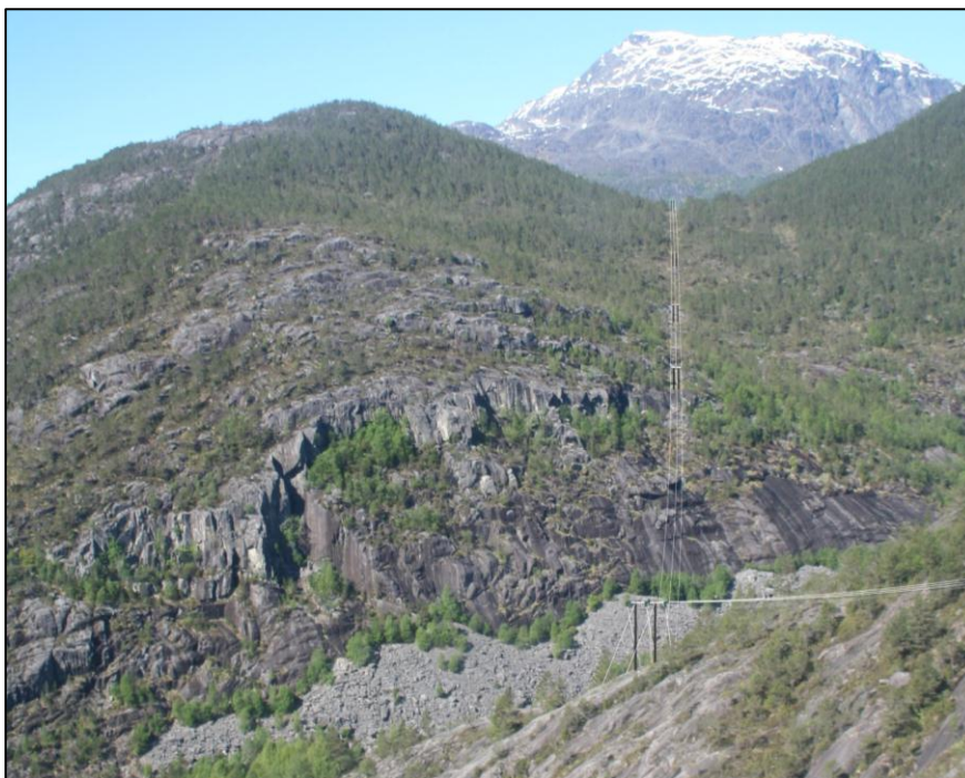
Figur 11: Visualiseringen viser kraftledningstraseen fra Mosnes til Glåmo. Skogryddingsbeltet blir utvidet med ca. 5 meter. I nedre kant av bildet vises spennet over Mosdal. Bilde fra SKL Nett.
