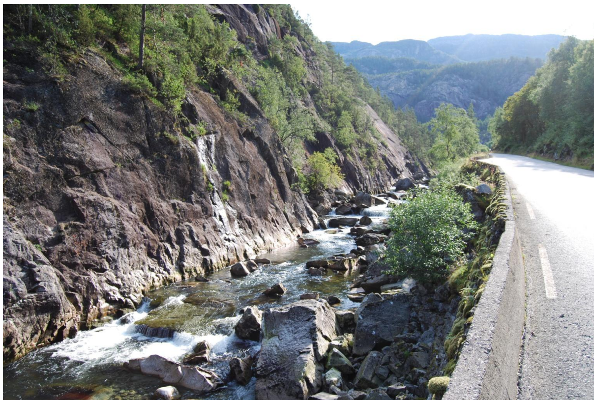
Figur 11-50: Gamlevegen går tett på Dalelva
