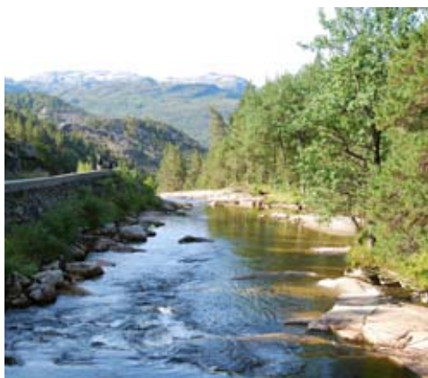
Inntak Skromme kraftverk i Dalelva, eksisterende situasjon.
