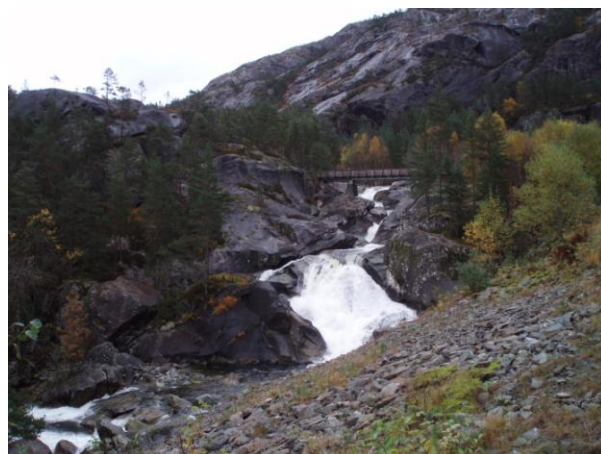
Figur 4-27: Postvegbrua Q=2,7 \text{ m}^3/\text{s} (24.10.06)
