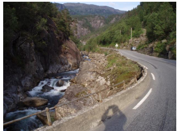
Figur 4-31 Dalelva oppstrøms Juv bru Q=1,50 \text{ m}^3/\text{s} (2.7.06)
