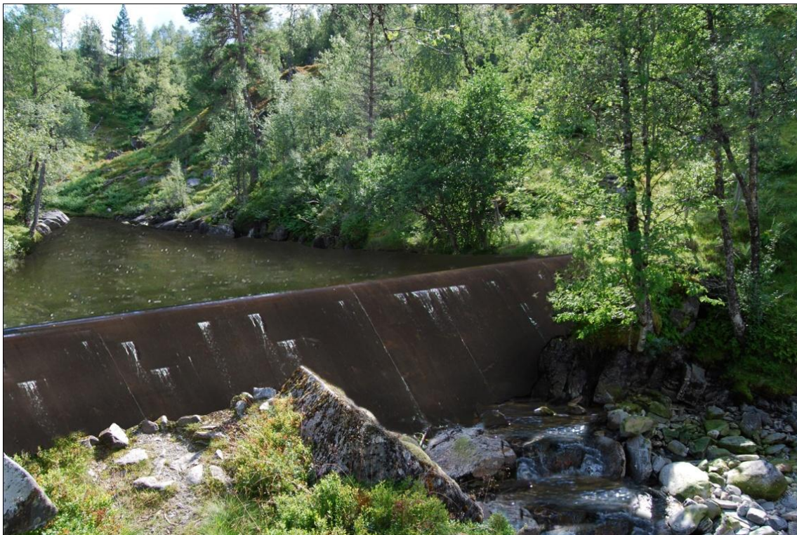
Figur 2-5: Bru på DNT-stien, mellom Bordals- og Mjølkestølen (over). Illustrasjon av planlagt dam (under)
