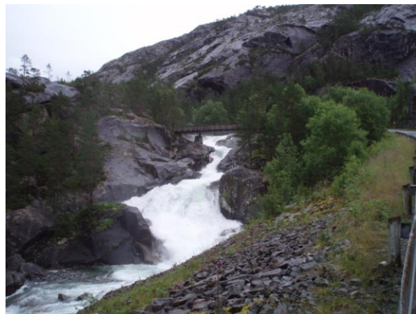
Figur 4-26: Postvegbrua Q=8,8 \text{ m}^3/\text{s} (3.7.07)
