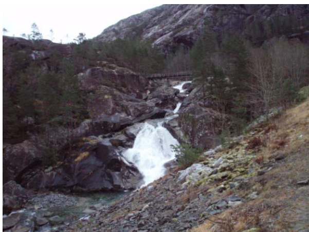
Figur 4-25: Postvegbrua Q=1,7 \text{ m}^3/\text{s} (29.12.06)
