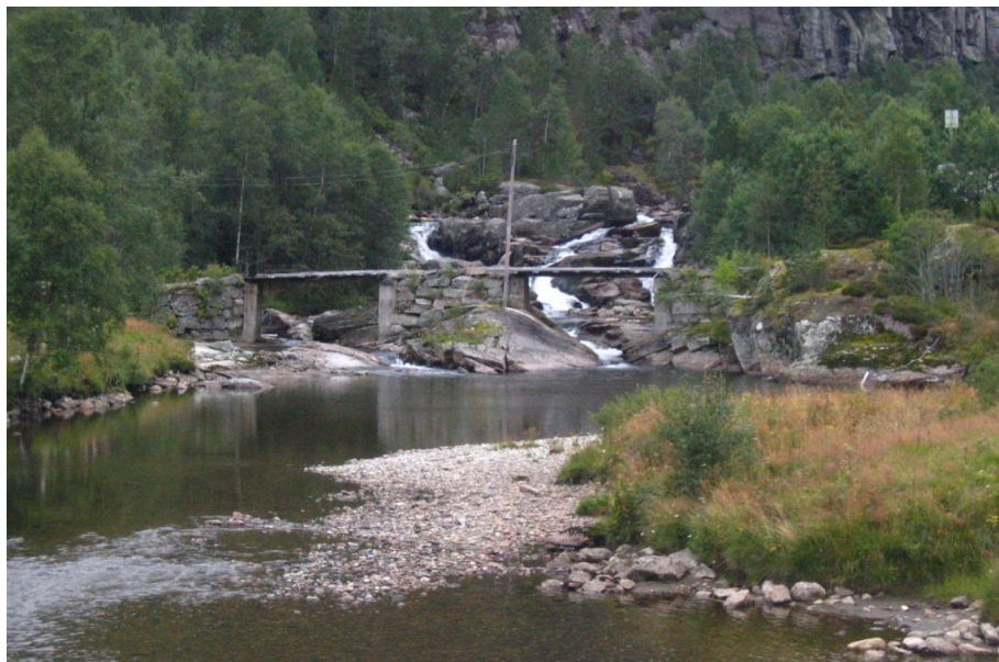
Figur 5-1: Skromme bru. Kraftstasjon for Skromme er planlagt i dette området
