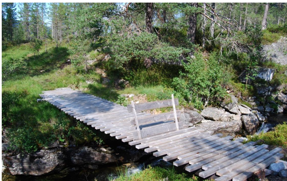
Figur 5-4: Bru over Skårselva
