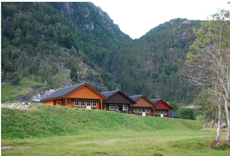
Figur 4-20: Fire nye utleiehytter på Halvfjordingen ved Rullestadvatnet
