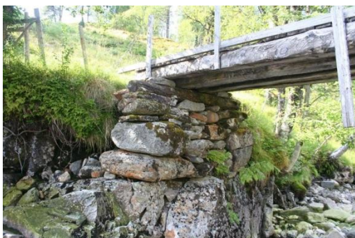
23. Brofundament Sted: Bordalselva SEFRAK-ID-nr.: Nyregistrert Registrert av: Torbjørn Røberg, Odel Dato: 18.8.2008
