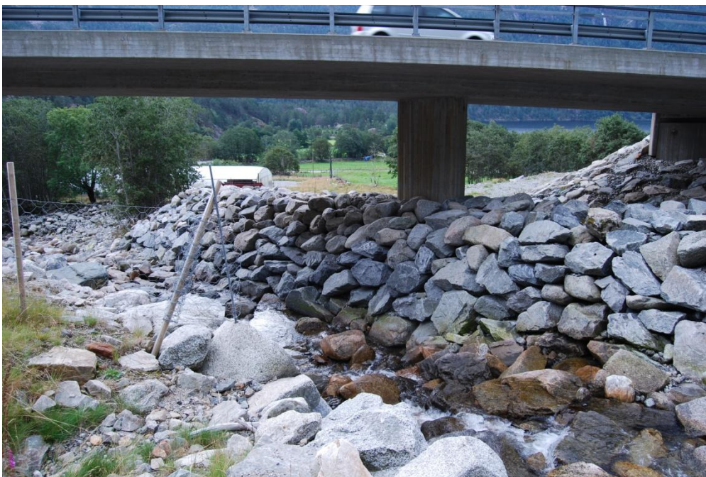
Figur 5-3: Ny E134 er lagt på bru over Kvernhuselva. I forbindelse med veibyggingen ble det gjort en del arbeider i elva
