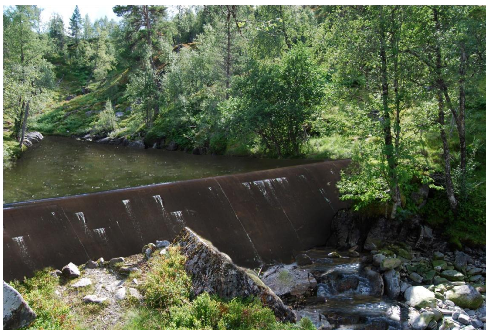
Figur 5-15: Bru på DNT-stien, mellom Bordals- og Mjølkestølen (over). Denne brua ble erstattet med en aluminiumsbru i 2010. Illustrasjon av planlagt dam (under)
