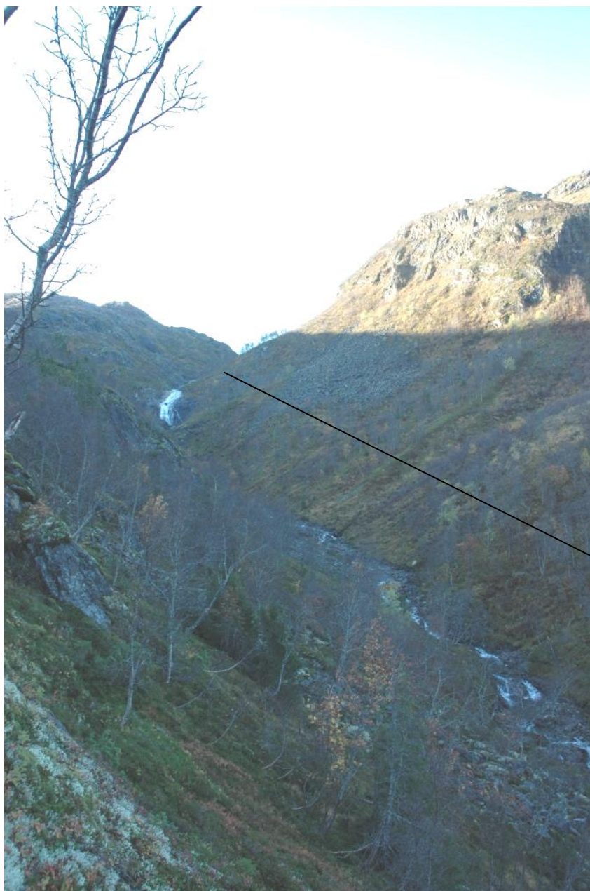
Bilde 3: Oversiktsbilde langs vannvei, inntegnet strek antyder omtrentlig vannvei
