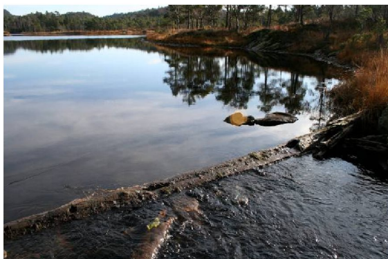
Figur 4.2. Rester av stem ved utløpet av Vikastølvatnet.
