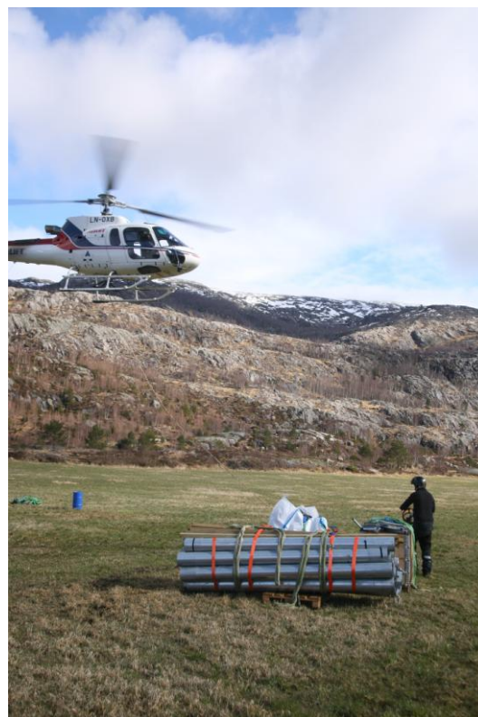
Helikoptertransport av vindmålemast inn til Stokkafjellet (Foto: Pete Seglem)
