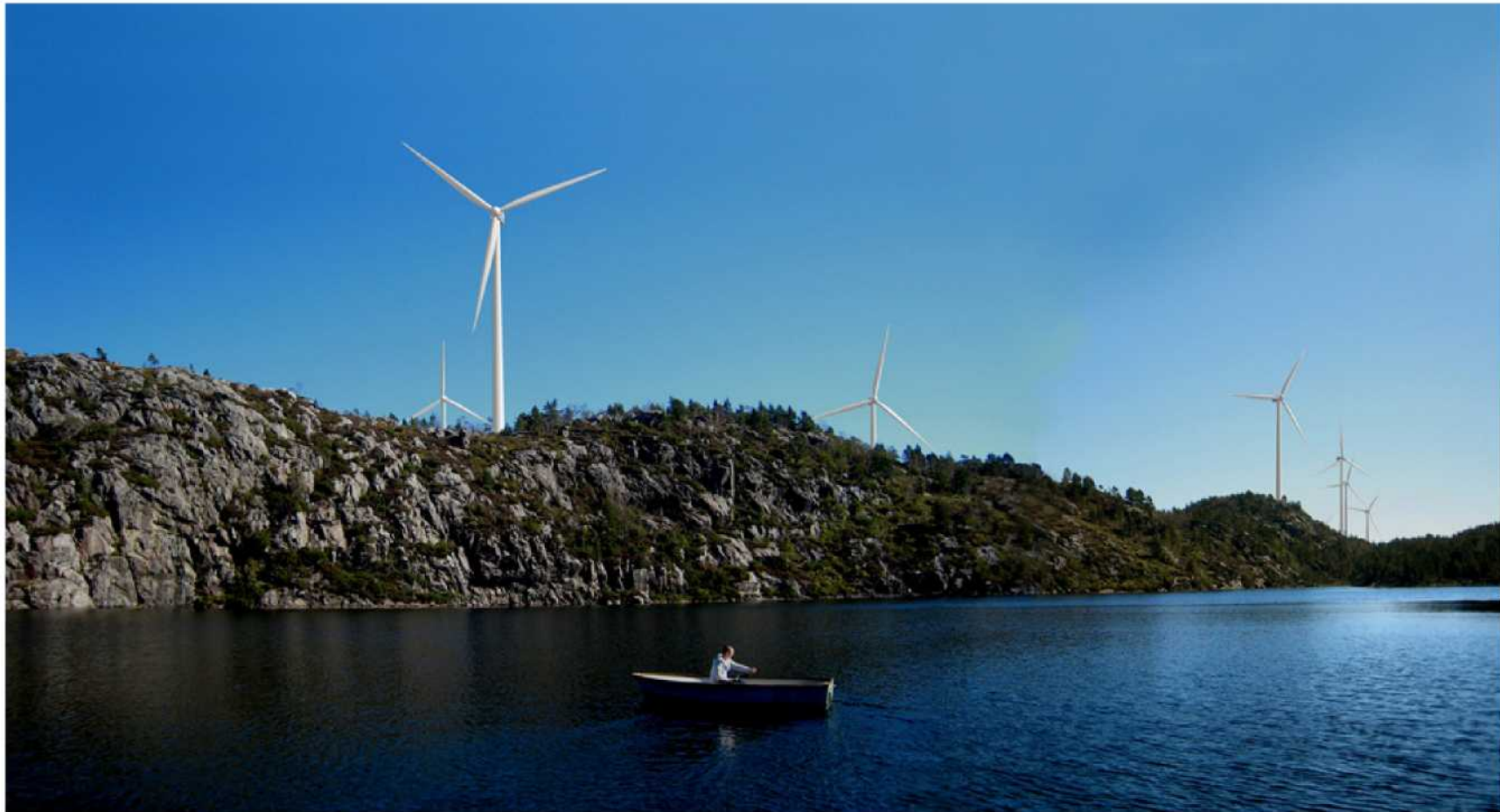
Figur 6.16. Visualisering av Skorveheia vindpark fra vestsiden av Torsvatnet
