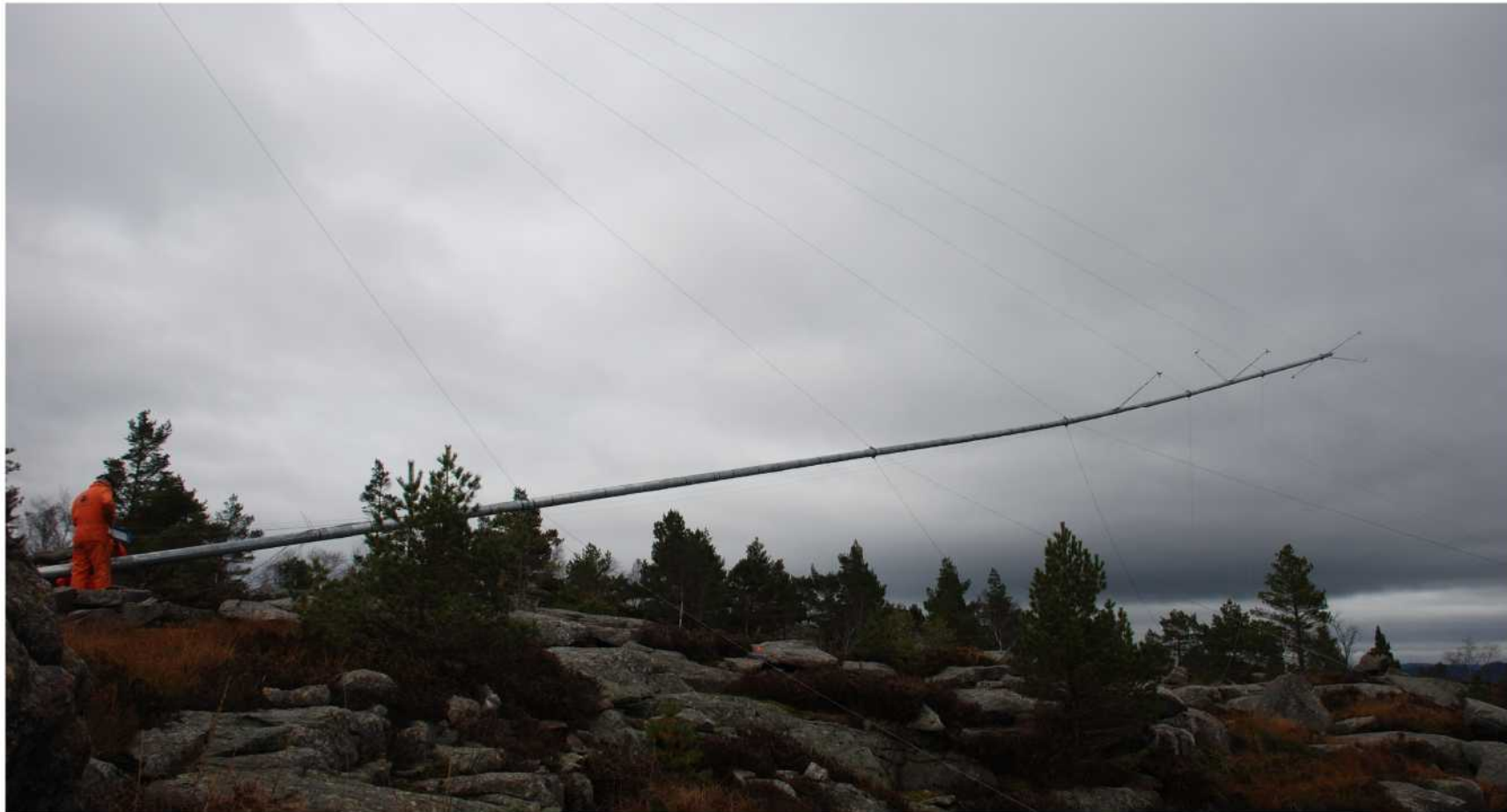
Figur 4.1. Heising av vindmålemast på Skorveheia
