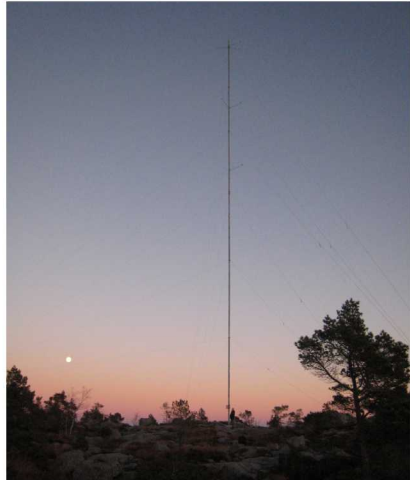
Figur 4.4. Vindmålemast på Skorveheia
