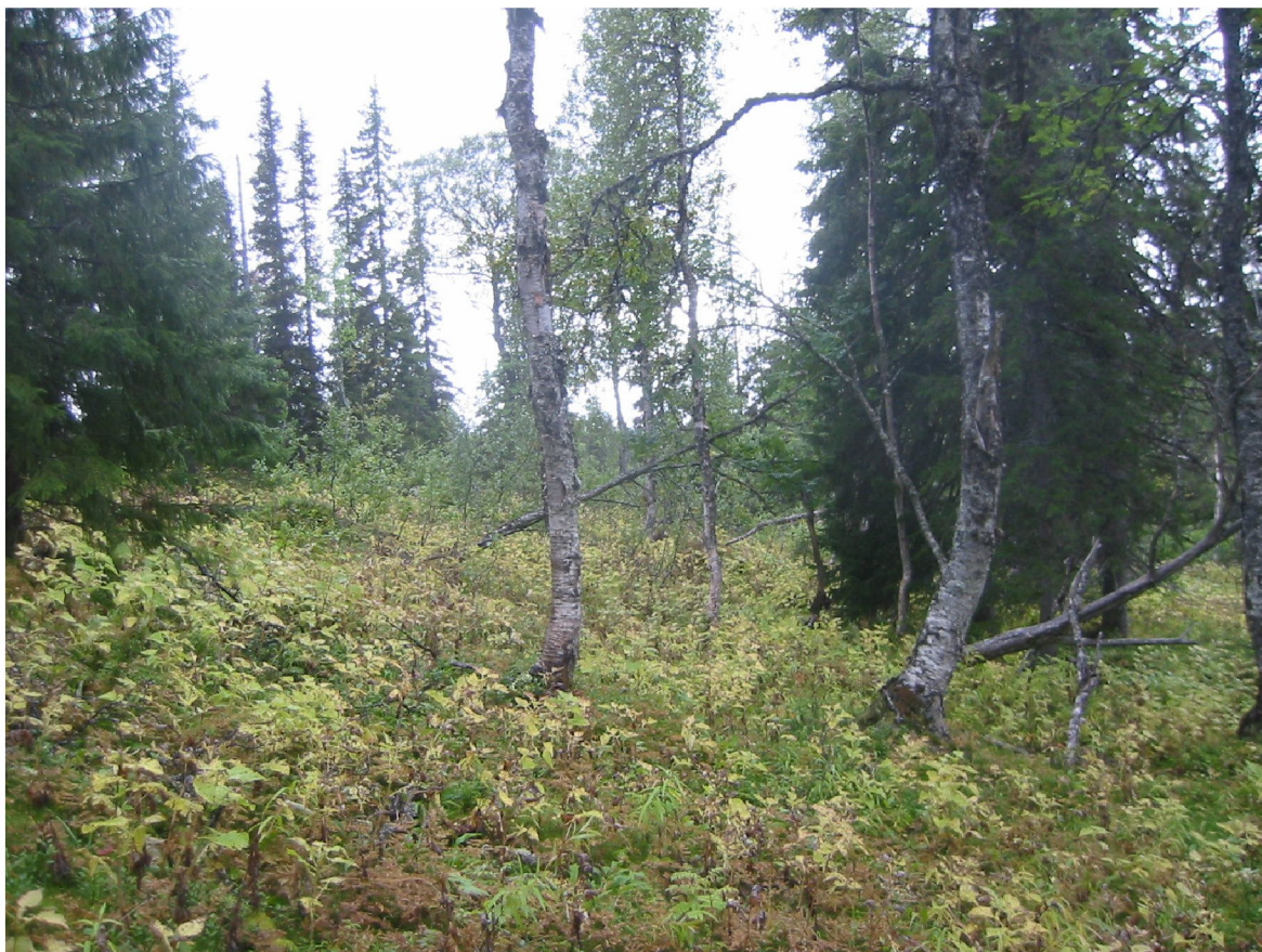
Bilde 3: Rørledningen graves ned i hele traseen, her typisk terreng fra sørsida av elva (12.09.05).
