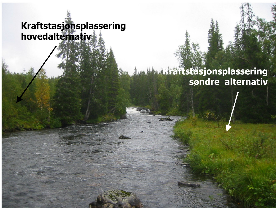
Bilde 4: Plassering av kraftstasjon, undervann ca kt +453,5. Sett motstrøms (12.09.05).
