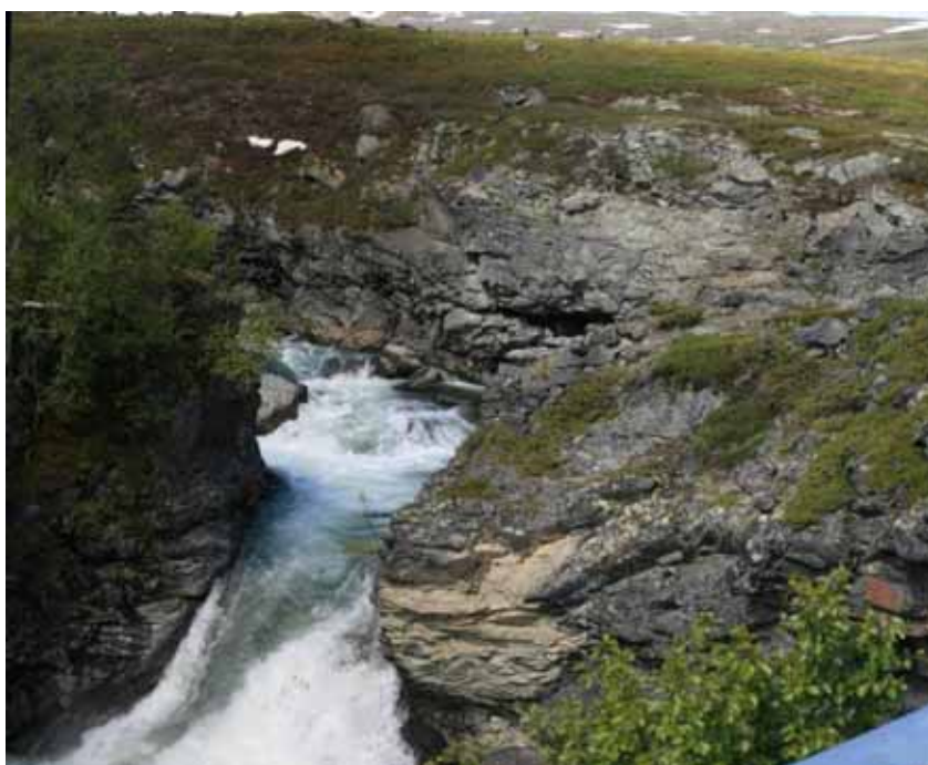
Figur 6-3 Dagens situasjon ved planlagt inntaksdam oppstrøms bru (alternativ 2) (Foto: Mona Mortensen, SWECO)
