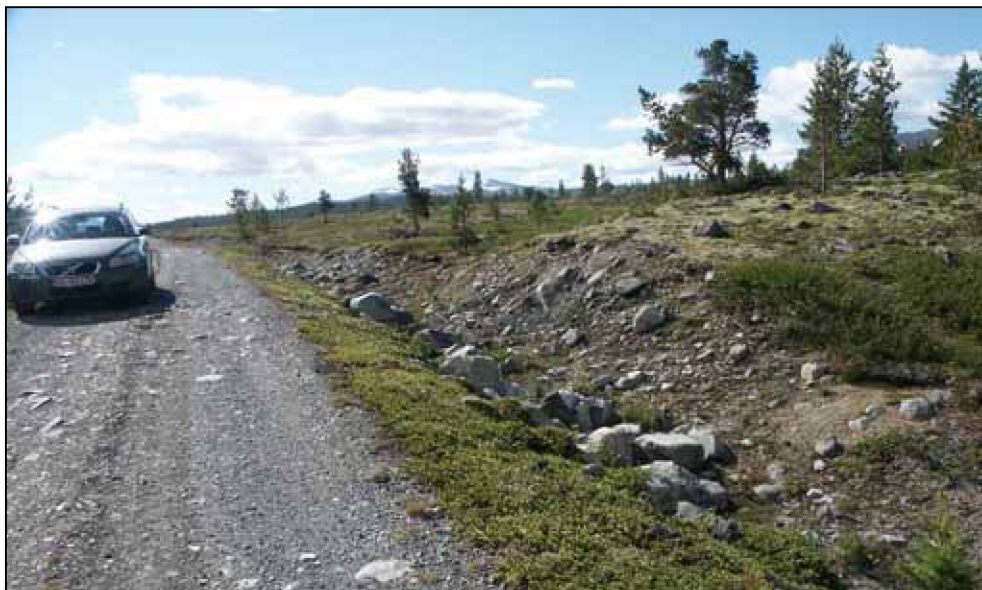
Figur 3.10 Veien langs Tesse berører eskersystemets nedre del. Drensgrøft ses langs veien.
