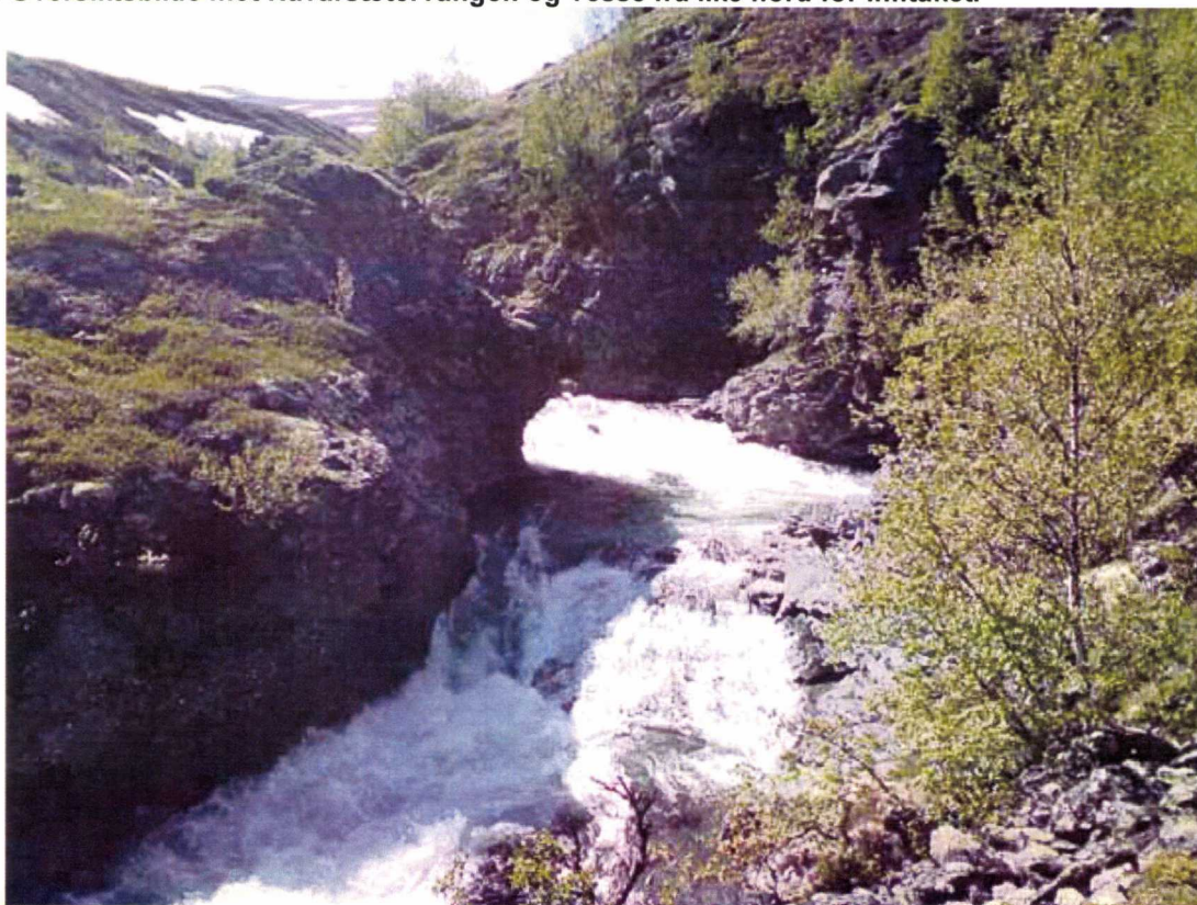
02 Inntak alt 1 sett fra nedstrøms side
