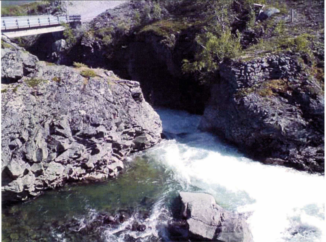
05 Inntak alt 2 sett fra oppstrøms side. Broen i bakgrunn til venstre
