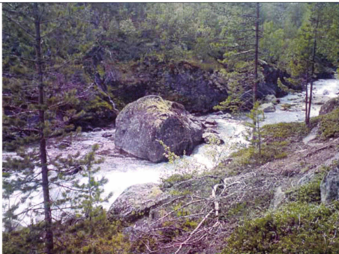
08 Steinblokken markerer hvor utløpstunnelen har utslag i elva
