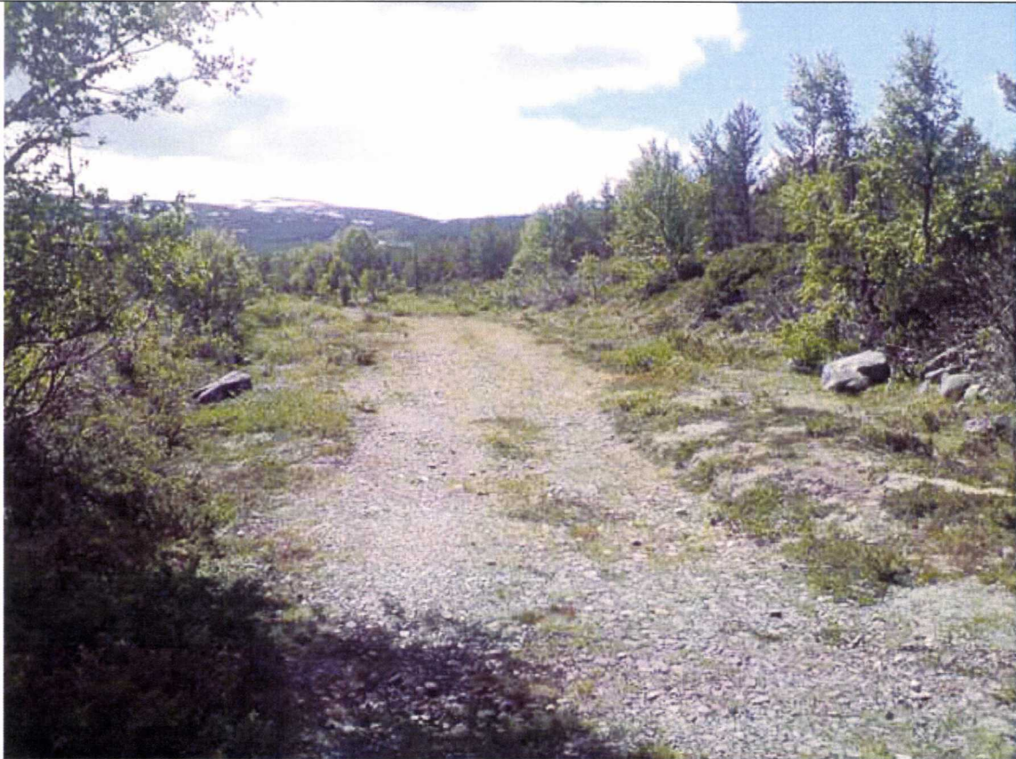
13 Kjerreveien over Nåvarsætervangen skal utbedres og benyttes som adkomstvei
