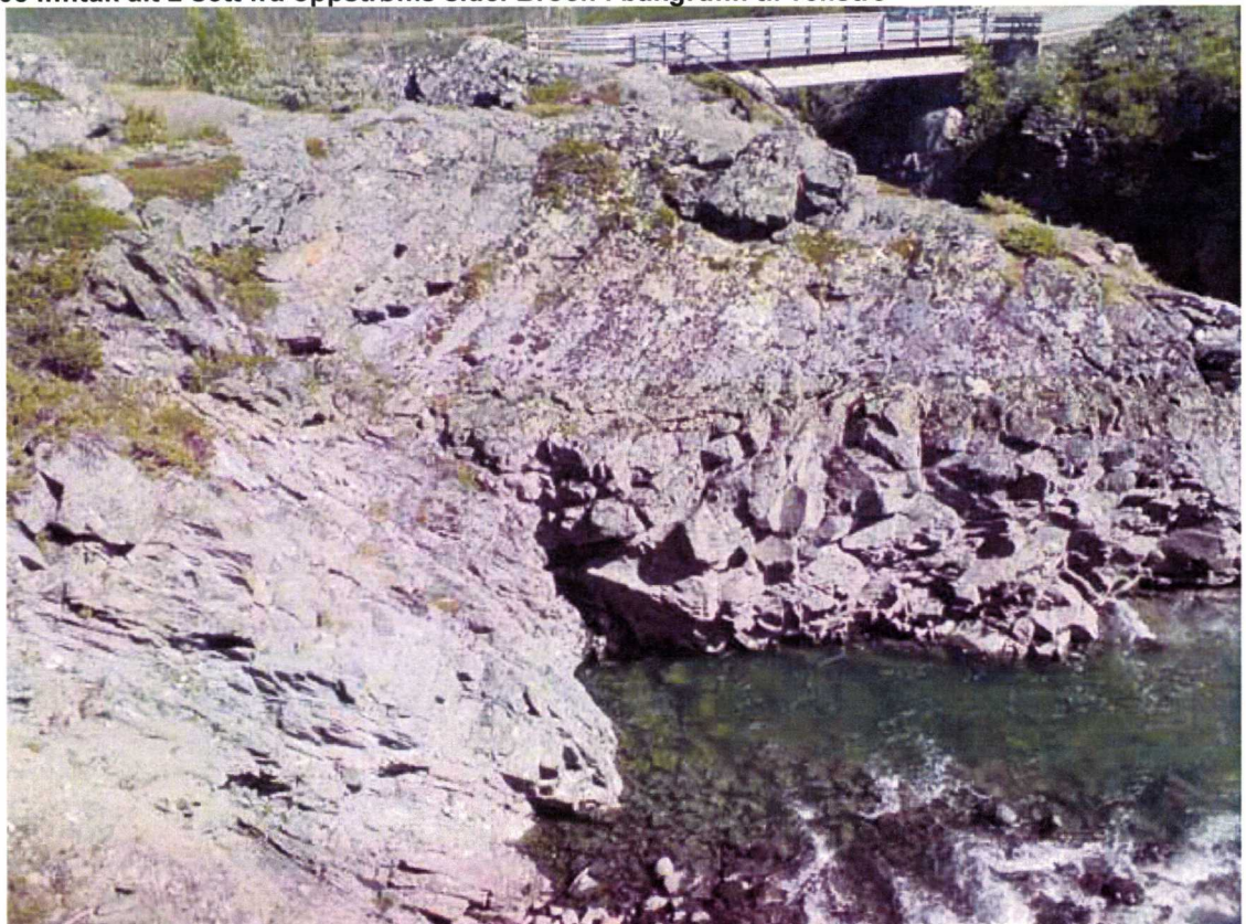
06 Inntak alt 2 sett fra oppstrøms side. Selve inntaket blir i kløfta midt i bildet
