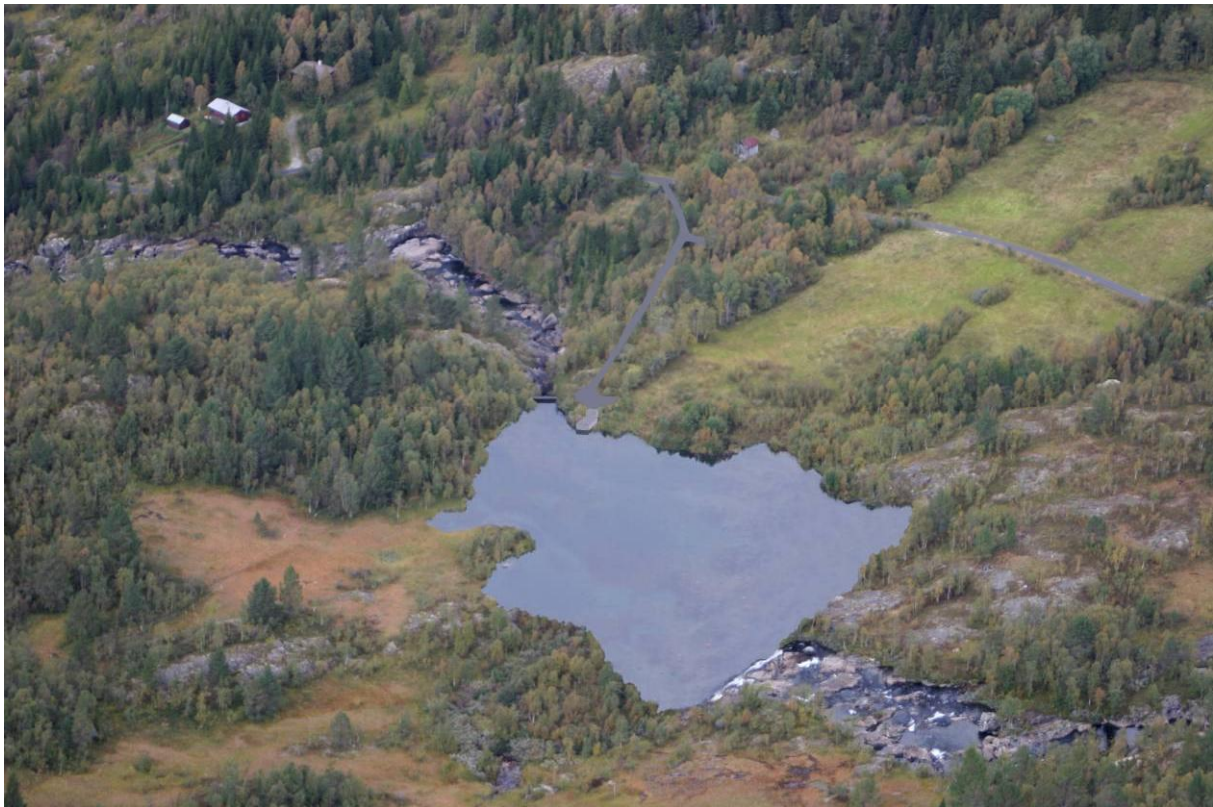
Figur 7.8. Inntaksbasseng og veiatkomst til anleggsstedet ved Syneshaug (visualisering Svein Erik Dahl)
