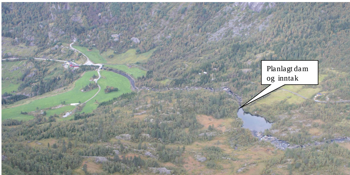
Figur 4.5. Inntaksområde ved Syneshaug. Vei opp til eksisterende tverrslag viser i bakgrunnen.
