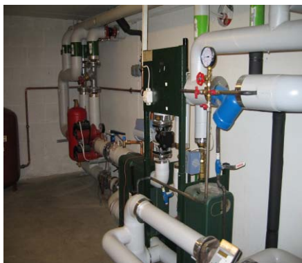
Kundesentral (foto: Energi & MiljøTeknikk AS og SGP VARMETEKNIKK AS)
