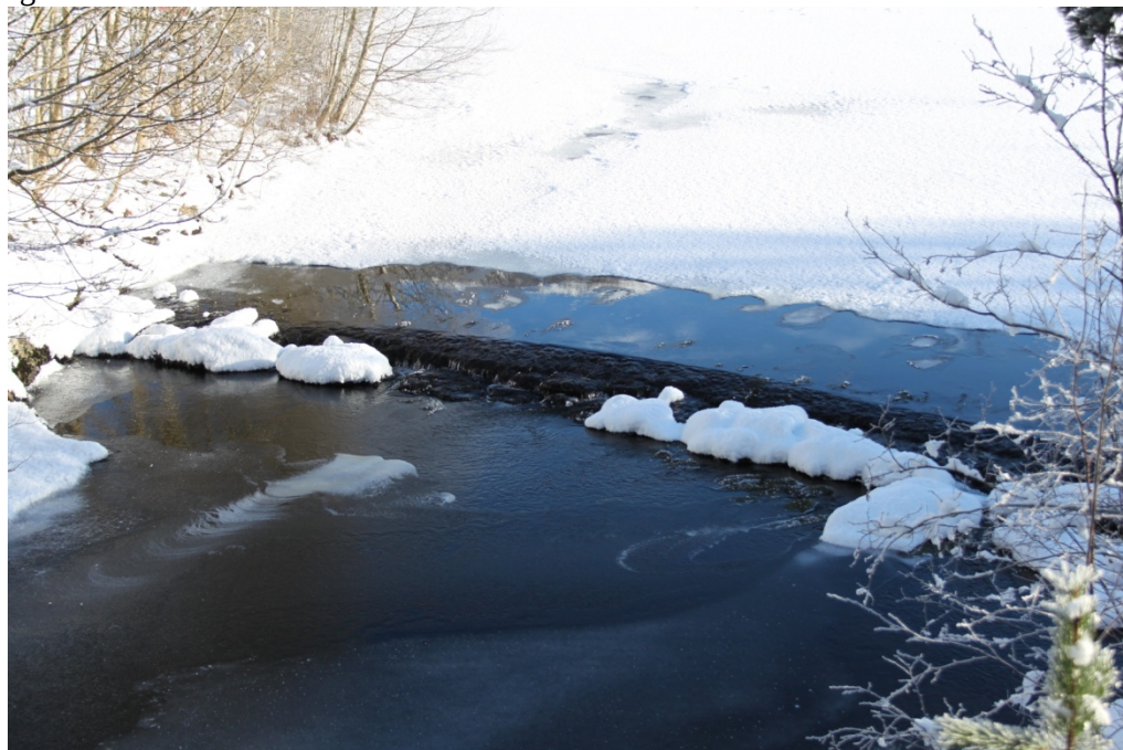
Bilde 3. Eksisterende terskel i Herandsvatnet.
