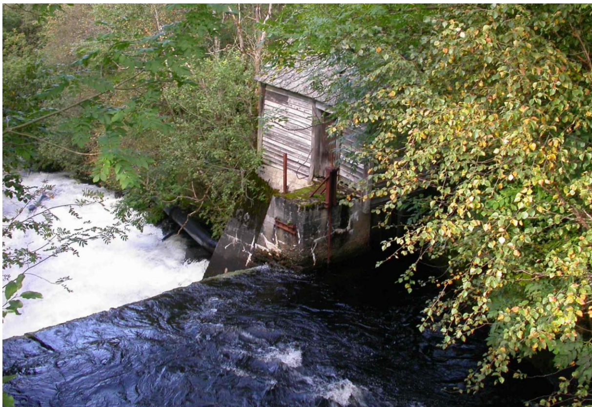
Figur 4. Biletet viser inntaket til det gamle kraftverket rett nedstraums utlaupet frå Herandsvatnet. Det er tanken å restaurera dette slik at det kan nyttast også til eit eventuelt nytt kraftverk i elva. (Foto; Finn Oldervik ©).
