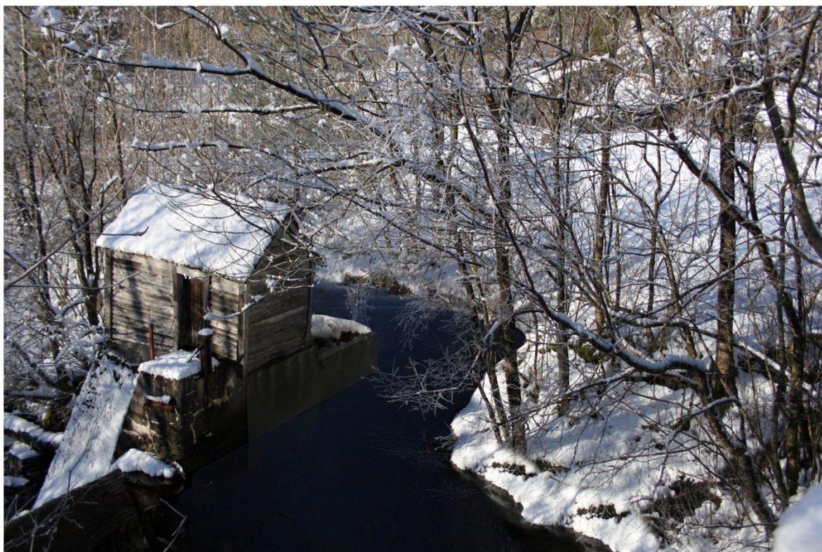
Bilde 2. Eksisterende dam nedstrøms Herandsvatnet før og etter utbygging.
