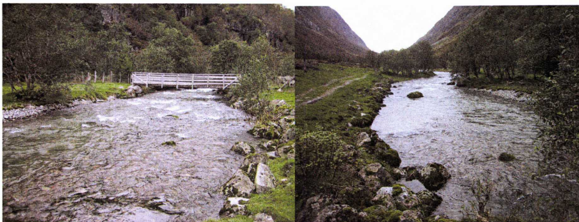
Stad for inntaket i Daleelva. Terskelen over elva kjem under brua og kanalen går ut på andre sida av elva og nedover.
