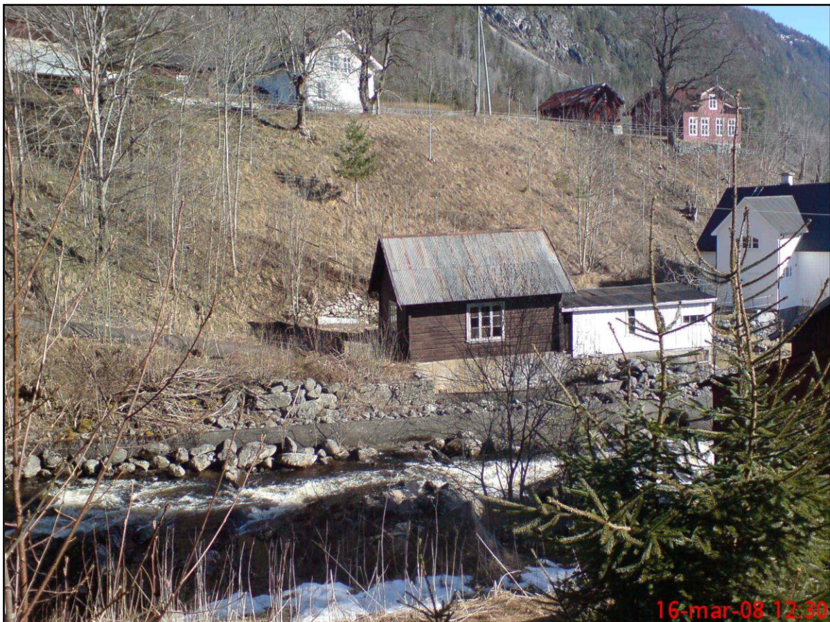
Innsyn mot kraftstasjonsområde på kôte 75, sett frå vestsida av Lårdalsåi
