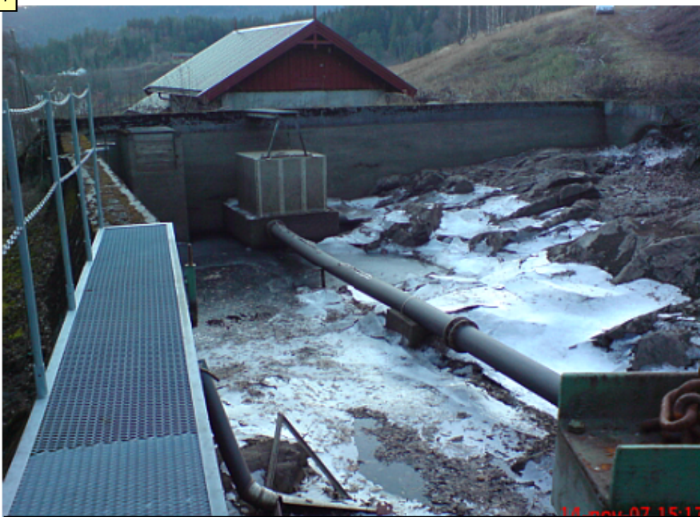
Inntaksdam m/teknisk bygg i bakkant (innehold borehol for vatn)
