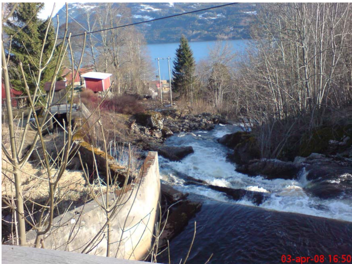
Bilde frå kote ca. 100 og ned mot kraftstasjonen
