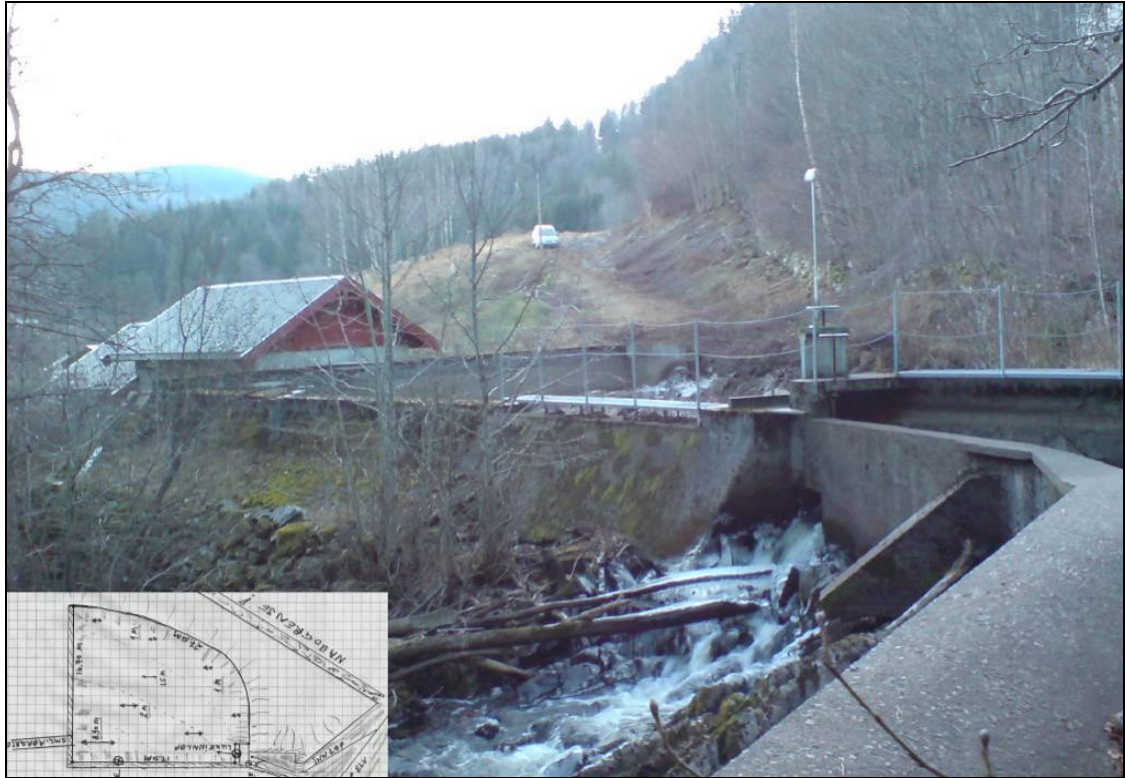
Figur 4. Kraftverksinntaket leggjast i eksisterende inntaksdam for nedlagd fiske-/smoltanlegg på vestsida av Lårdalsåi, kote 166. Foto: Clemens Elvekraft AS.
