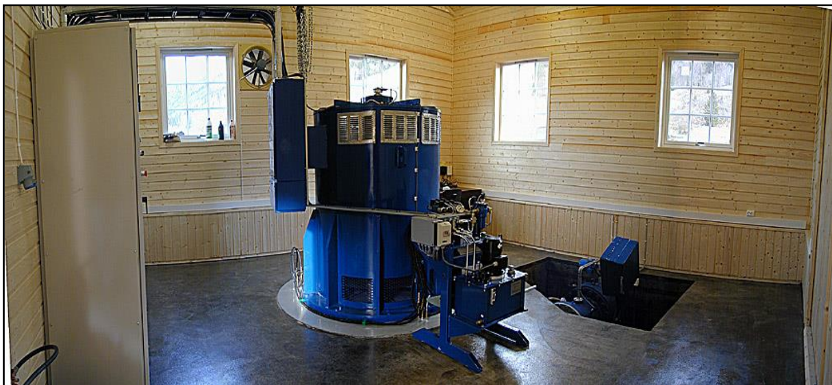
Eksempel på teknisk løysing med vertikal norskprodusert peltonturbin
