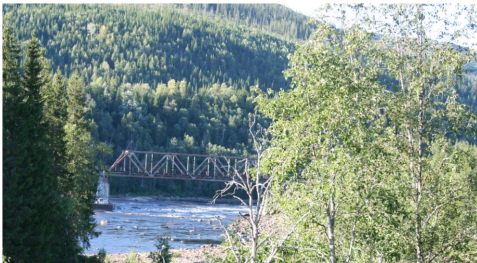
Jernbanen krysser Namsen like oppstrøms planlagt inntaksmagasin
