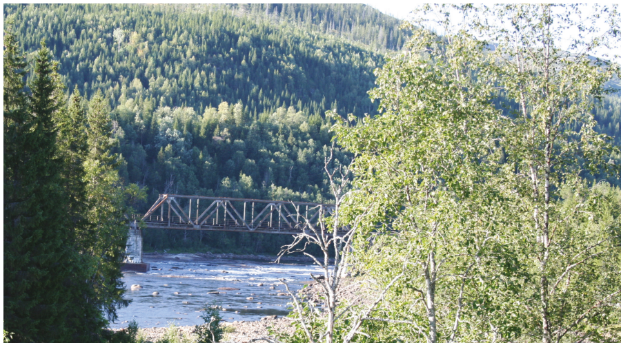
Figur 5-7 Jernbanebrua over Namsen, like oppstrøms planområdet (Foto: M. Mortensen, Sweco, aug. 2008)
