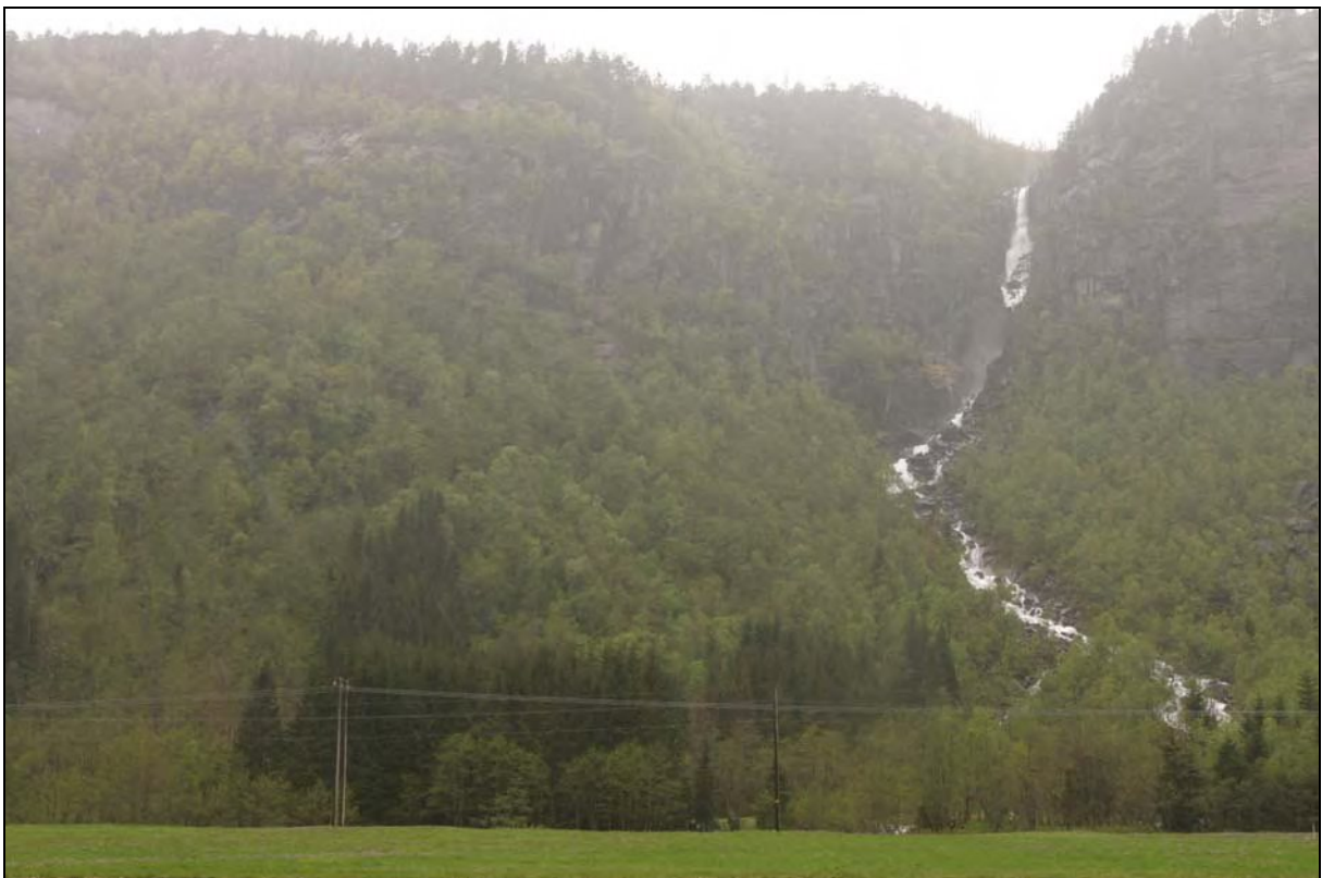
Figur 4. Tverrgjuvlo sett fra Langeland i Teigdalen. Kraftstasjon, tunnelpåhugg og rørgate er planlagt lokalisert i området ved plantefeltet eller like til venstre for dette.
