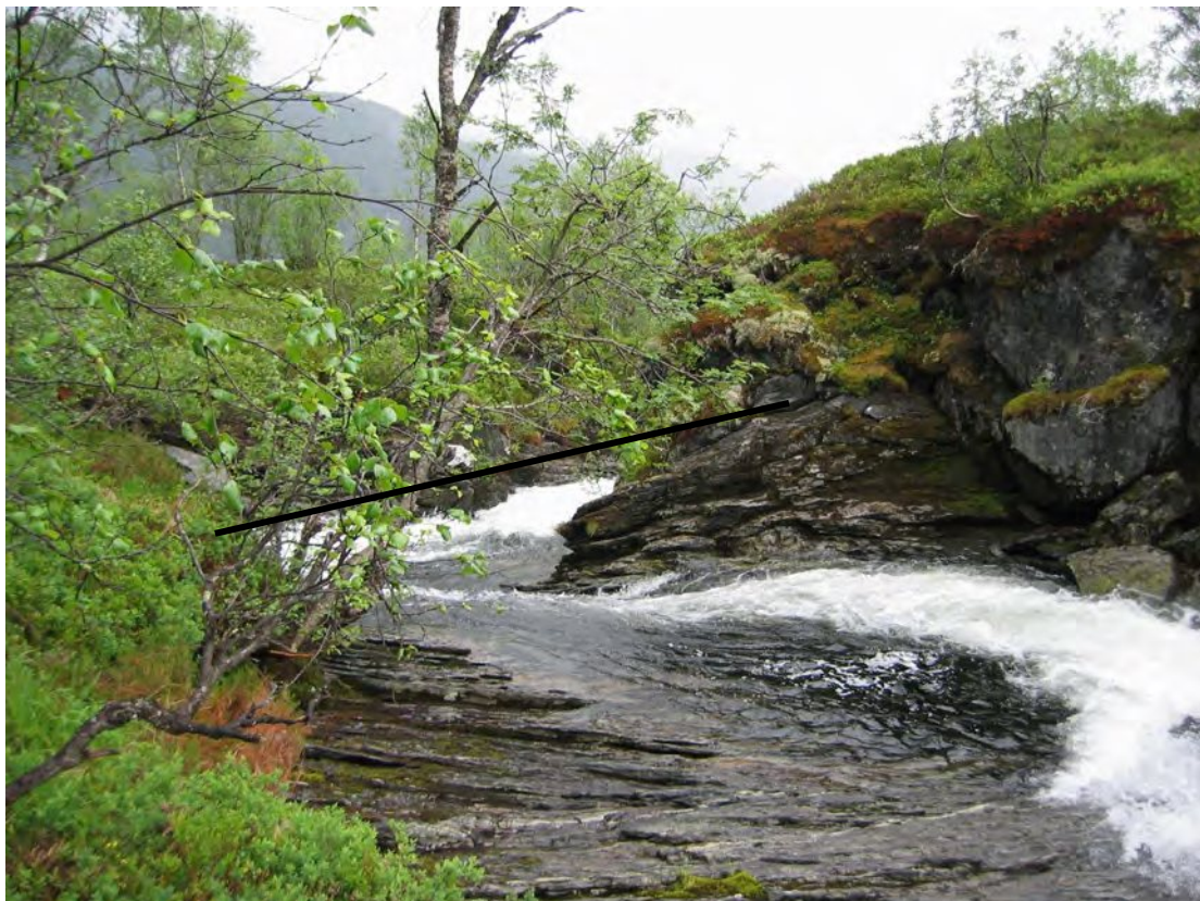
Utløp av lone, Inntaksdam vert bygt her. Inntakskonstruksjon på høgre side av bilde
