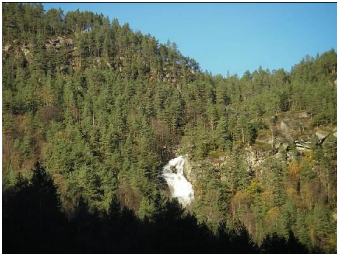
Figur 12: Vannstrengen sett fra åsen ved stasjonsområdet. Øvre del av konsentrert fallstrekning. (Foto: Karttjenester.)
