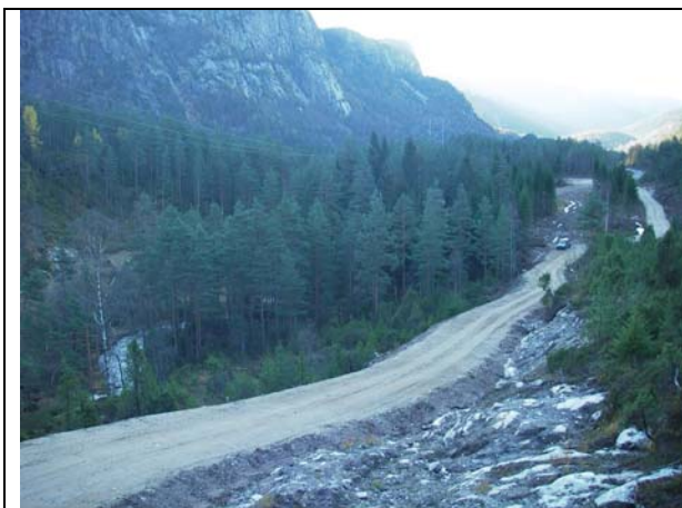
Bilde 2 til venstre viser adkomstveien fra gårdene ved Bjunes. Kraftstasjonen vil bli plassert mellom den nye skogsbilveien og elva til venstre i bildet.
