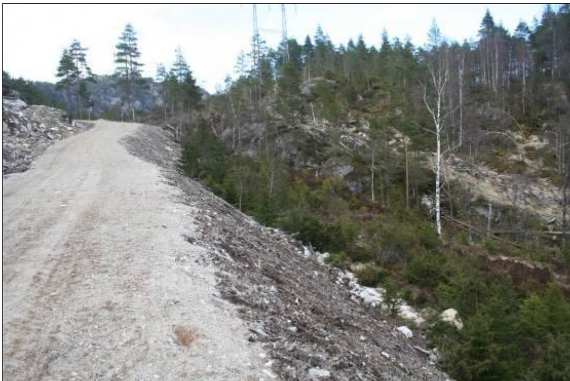
Figur 5: Rørgata kommer fra stasjonene ned i høyre bidekant for så å fortsette opp til svingen av veien. Rørgata fortsetter videre i veien.
