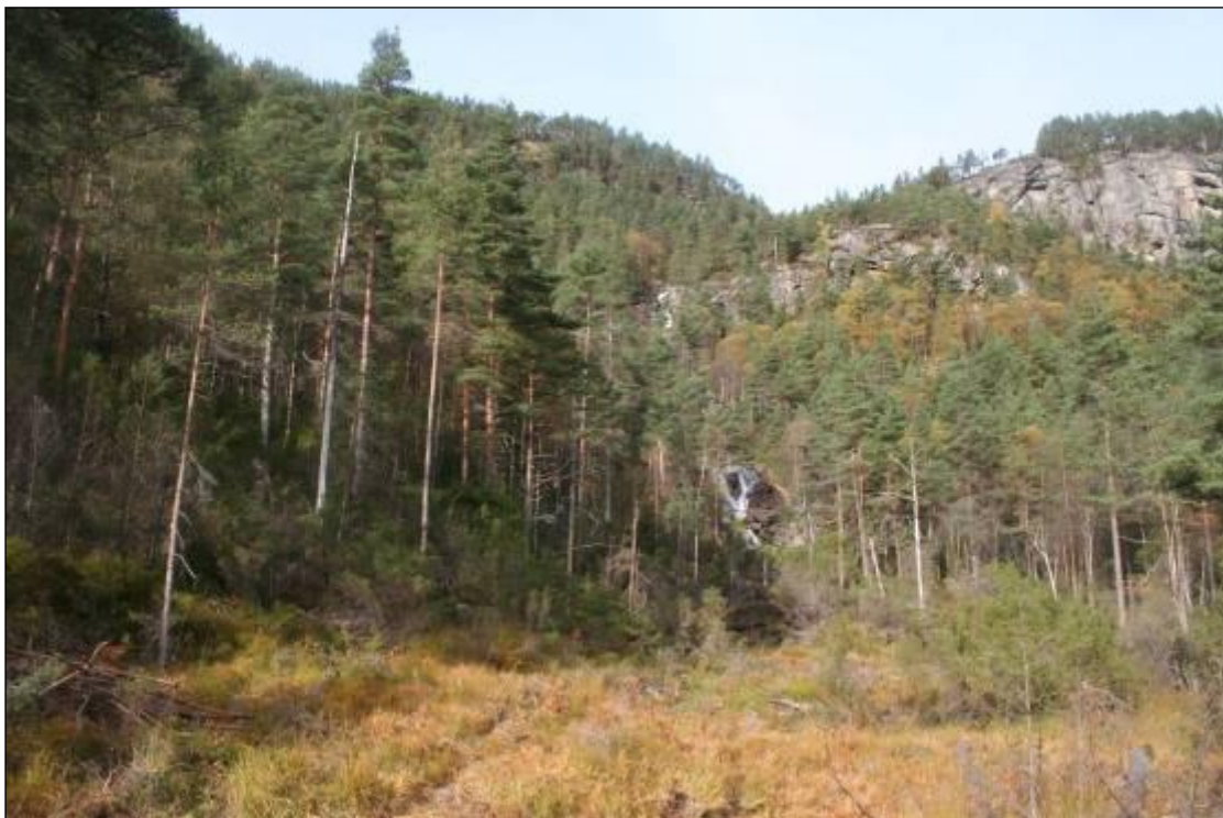
Figur 11: Vannstrengen sett fra enden av landbruksvei. Påhugget blir til venstre for nederste synlige del av vannstrengen i bildet. Landbruksveien vil bli forlenget videre framover mot påhugget. (Foto: Karttjenester.)
