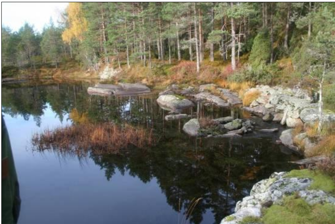
Figur 22: Gammel dam i det nordlige utløpet sett mot vest. Ny dam blir i forkant av den gamle.
