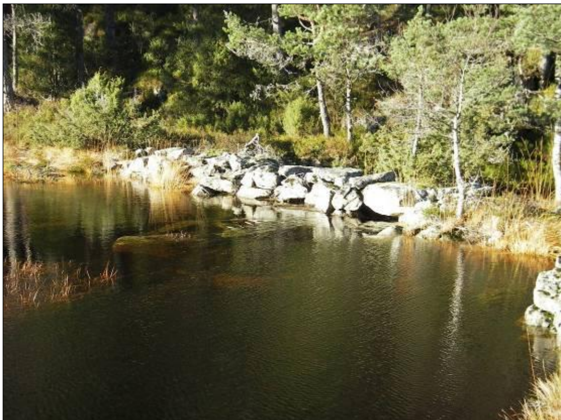
Figur 26: Gammel dam i nordlig utløp, nå med høyere vannstand i Haugevatnet. (Foto: Karttjenester.)
