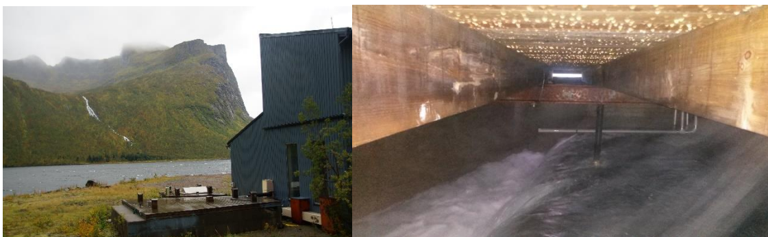
Bilde 7. Kum for vanninntak etter turbin Bergsbotn kraftverk.
