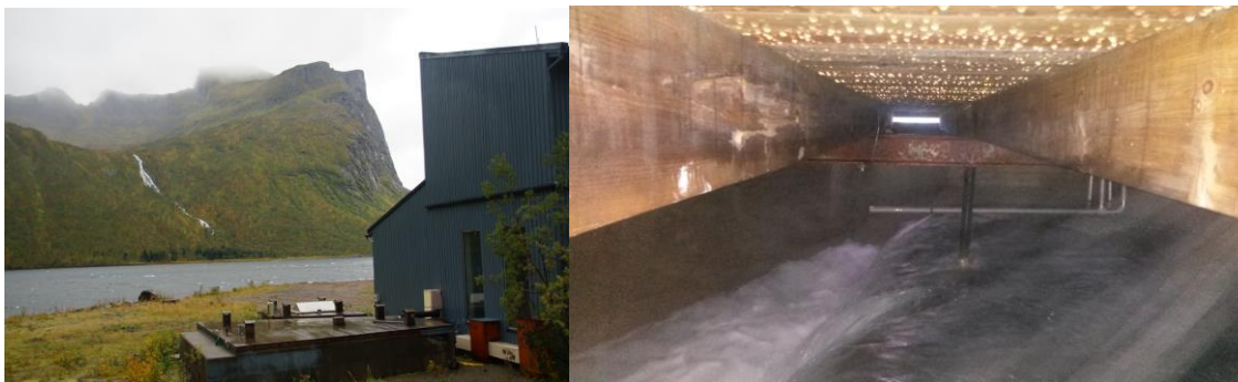
Figur 1.4 Kum for vanninntak etter turbin Bergsbotn kraftverk.
