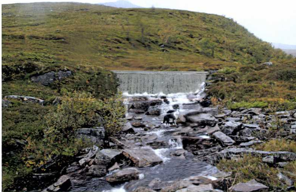
Før- og ettersituasjon for inntaksstedet ved Skarbøelva, sett nedenfra. 3D-modellering og fotomanipulering: Alvestad Arts
