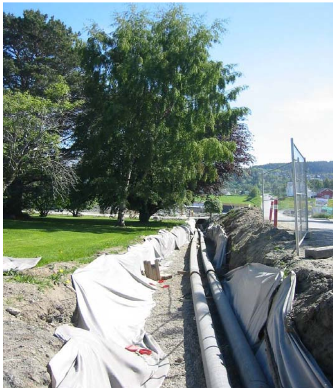
Bilde av en fjernvarmetrasé.
